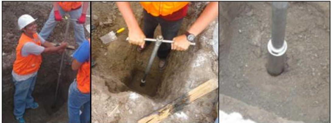
(c) Perforación con posteadora
