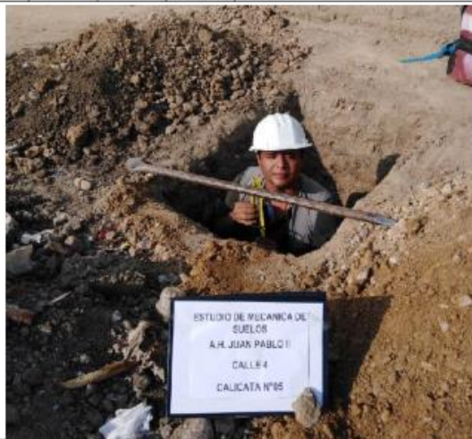
Figura 29. Estratigrafía de excavación: C-5 Elaborado por: los autores
