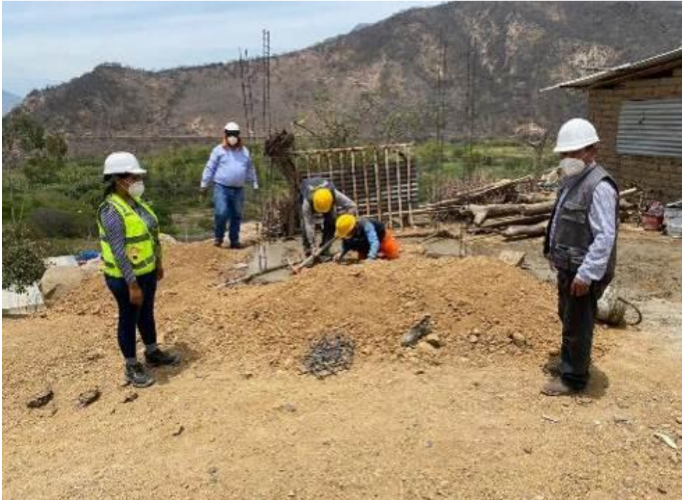
Fotografía 3: Vaciado de concreto simple en cimientos de la M-7, sector 1- Caserío de Guayabo.
