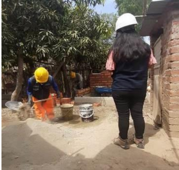
Fotografía 31: Se observa la aplicación de la carta balance en el asentado de ladrillo para muros en M- 18 , caserío Guayabo.
