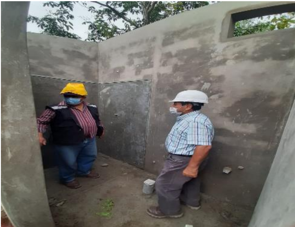
Fotografía 40: Se observa trabajos de tarrajeo interior en M-15, caserío Guayabo.
