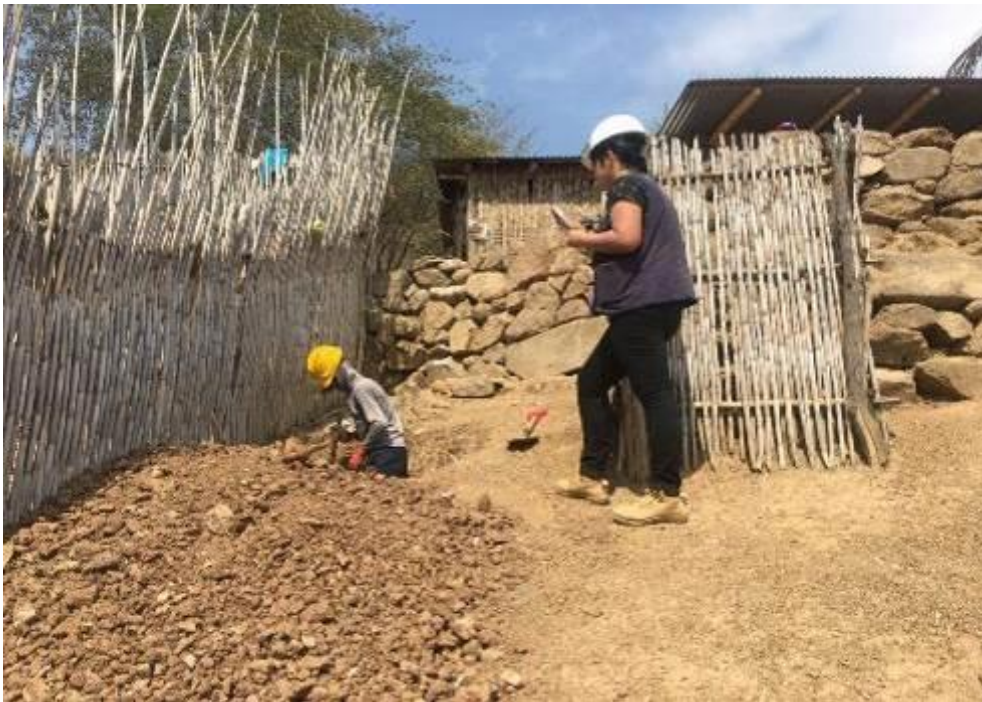
Fotografía 28: Se observa la excavación manual de los cimientos del Biodigestor de la UBS.
