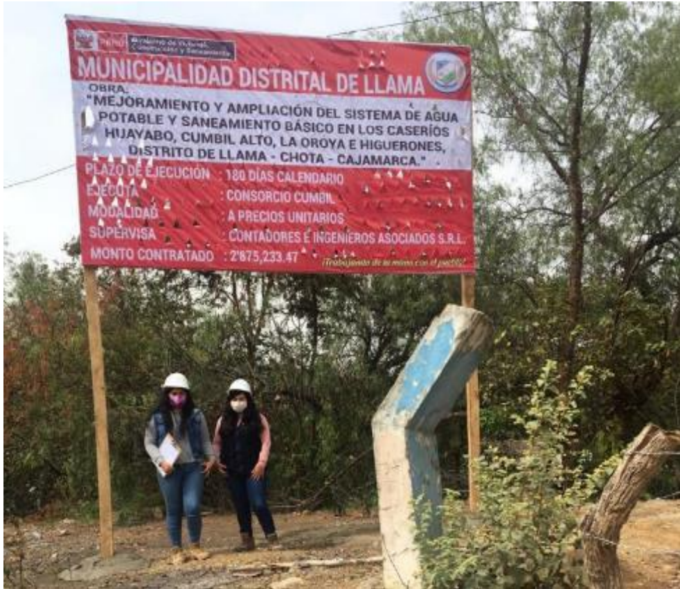
Fotografía 1: Se observa el cartel de obra
