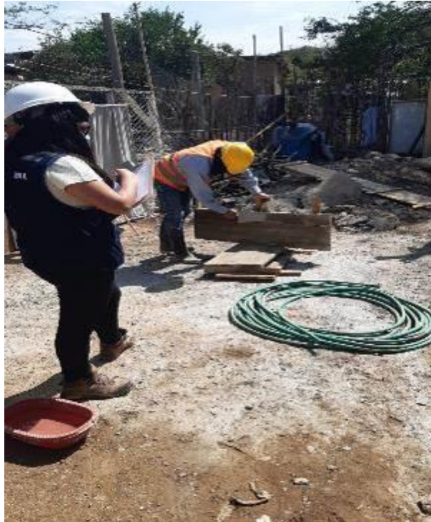
Fotografía 23: Se observa la aplicación de la carta balance en el desencofrado del sobrecimiento en M-45, ubicada en el caserío Higueroes.
