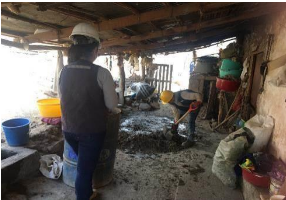
Fotografía 26: Se observa la aplicación de la carta balance en vaciado de concreto en el sobrecimiento de la M-53, en el caserío de Higueroes.
