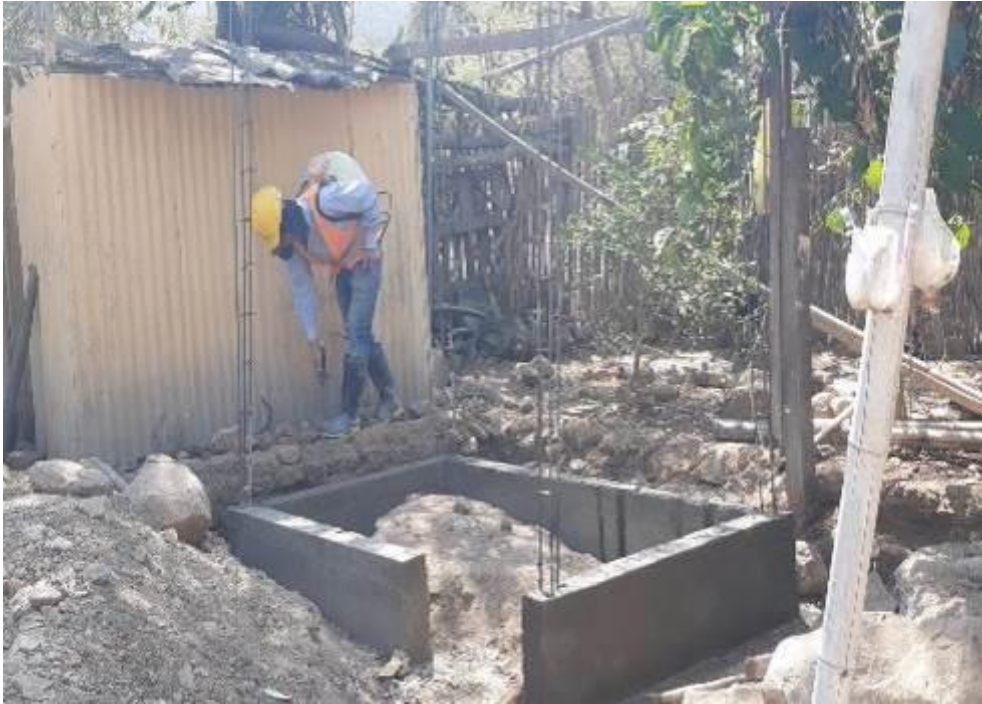
Fotografía 21: Curado del concreto del sobrecimiento
