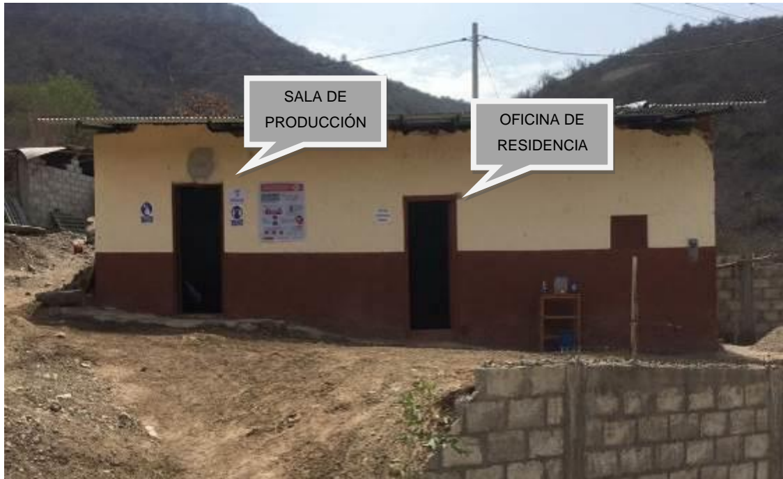
Figura 42. Vista frontal de la sala de producción
