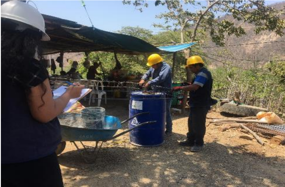
Fotografía 29: Se observa la aplicación de la carta balance en la habilitación del acero para vigas.
