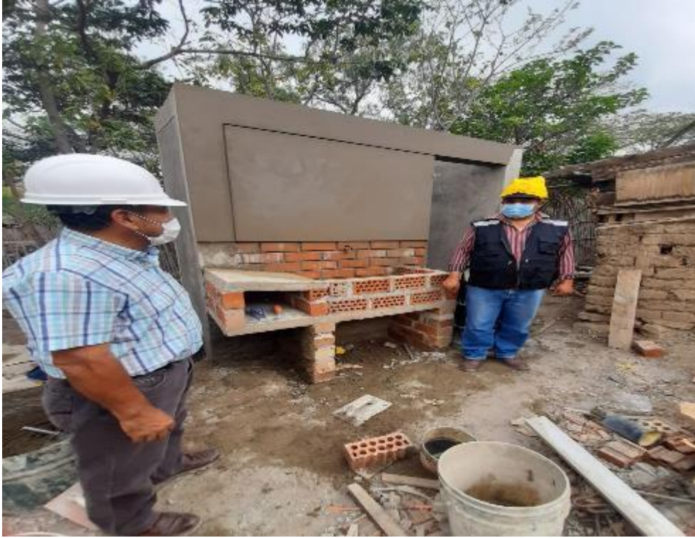
Fotografía 39: Se observa trabajos de tarrajeo exterior en M-15, caserío Guayabo.
