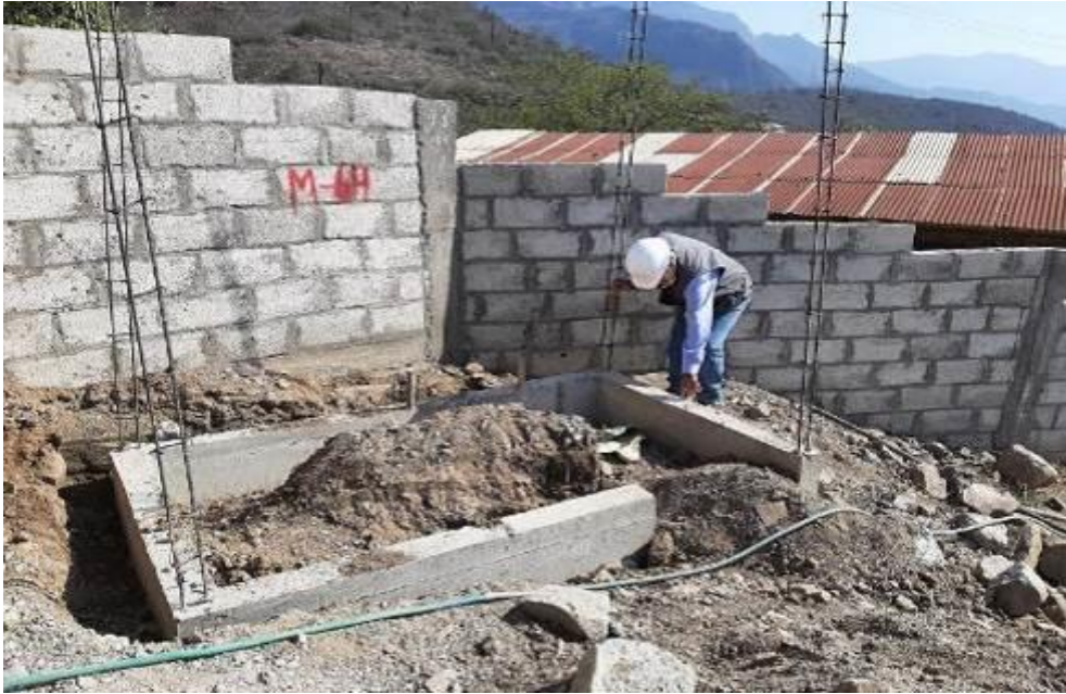
Fotografía 11: Se observa el sobrecimiento vaciado con concreto simple en M-64, ubicada en el caserío Cumbil Alto.
