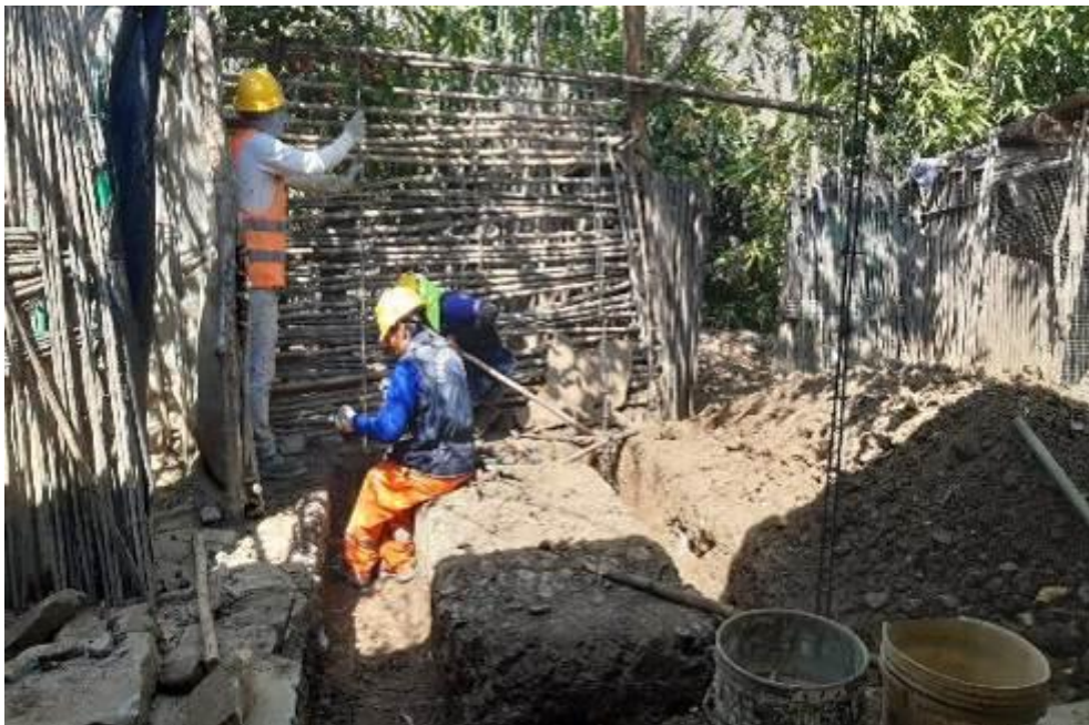
Fotografía 22: Trazo y replanteo de la cimentación de la M-40, en el caserío de Higueroes.
