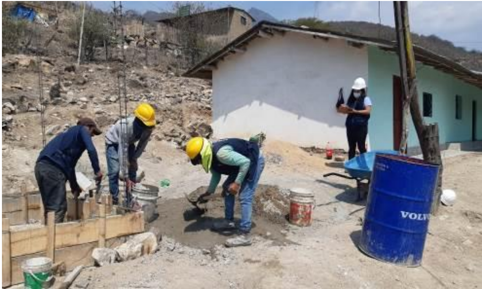
Figura 36. Ubicación en el punto de obra
