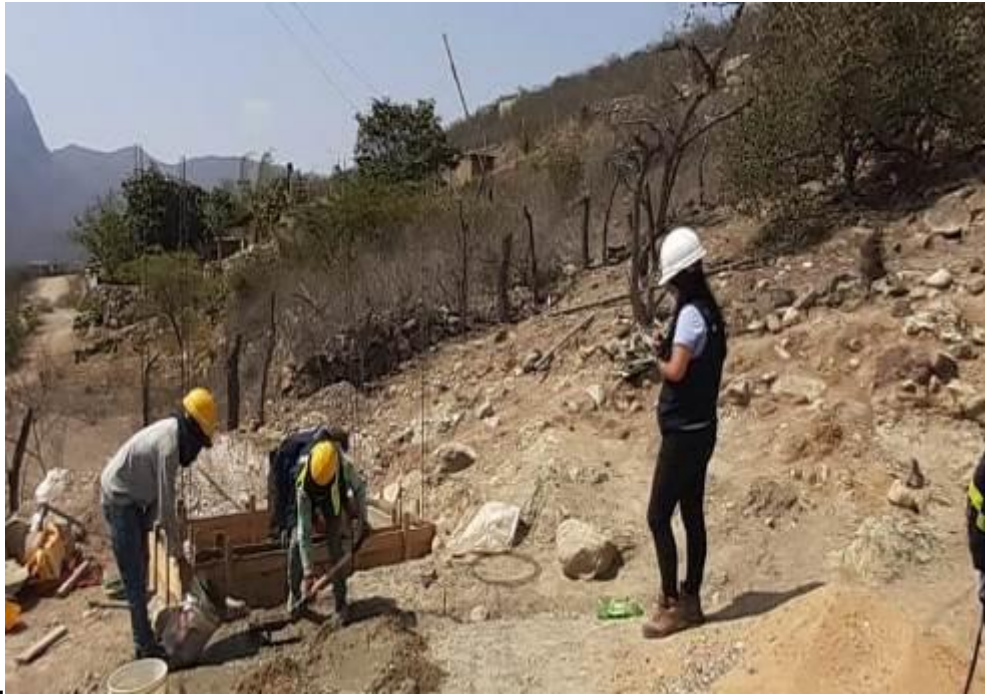
Fotografía 13: Vaciado de concreto simple en sobrecimiento en M-10, ubicada en el caserío la Oroya
