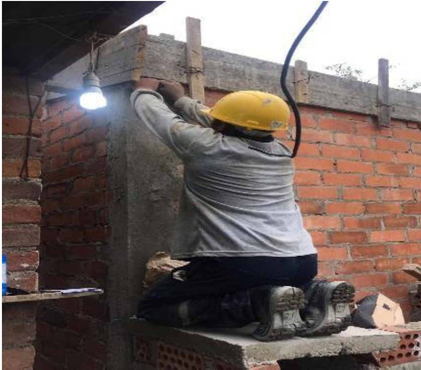
Fotografía 37: Se observa el encofrado de la viga en M-37, caserío Cumbil Alto.
