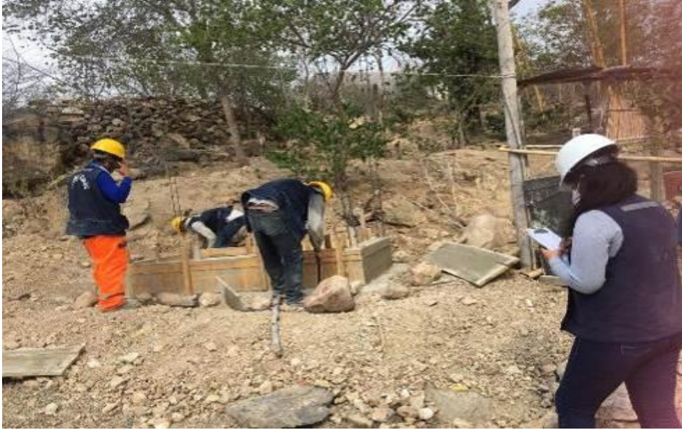
Fotografía 17: Se observa la aplicación de la carta balance en el desencofrado del sobrecimiento en M-15, ubicada en el caserío la Oroya.
