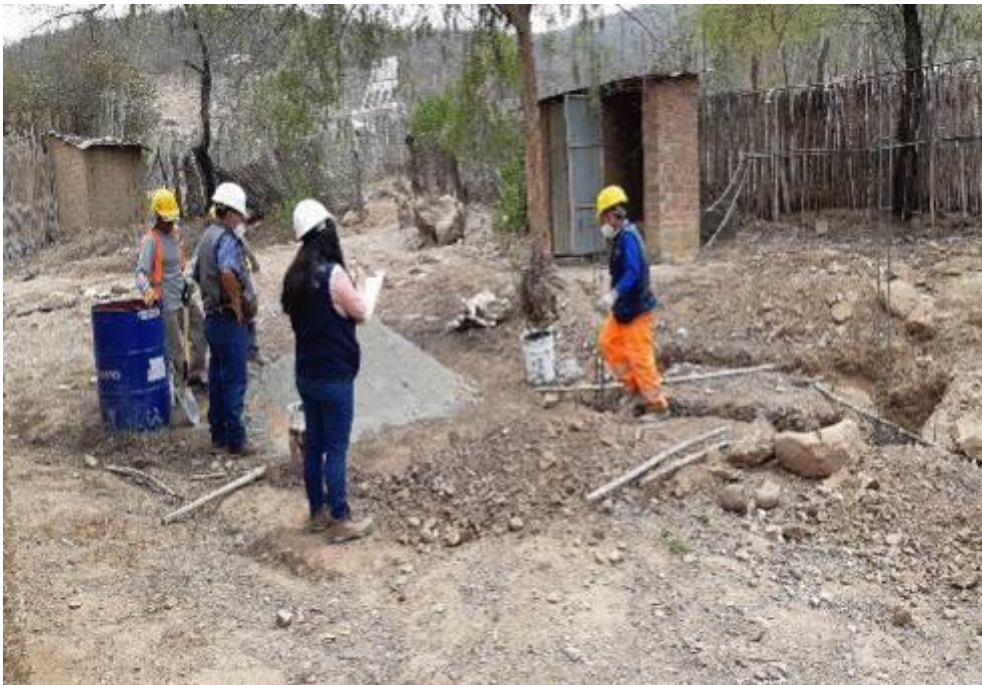
Fotografía 4: Vaciado de concreto simple en cimientos de la M-9, sector 1- Caserío de Guayabo.
