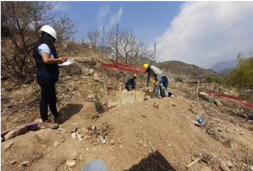
Fotografía 12: Se observa la aplicación de la carta balance en el encofrado y desencofrado del sobrecimiento en M-7, ubicada en el caserío la Oroya
