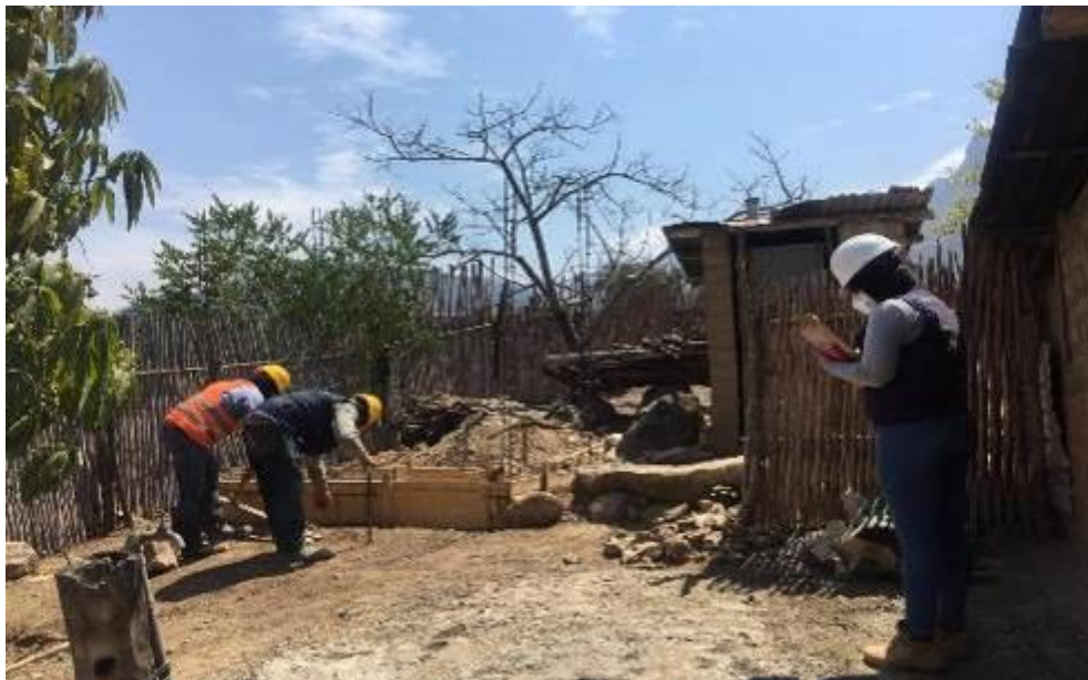
Fotografía 24: Se observa la aplicación de la carta balance en el encofrado del sobrecimiento en M-49, ubicada en el caserío Higueroes.
