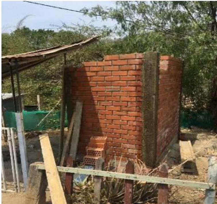
Fotografía 34: Curado de columnas en M-40, caserío Cumbil Alto.
