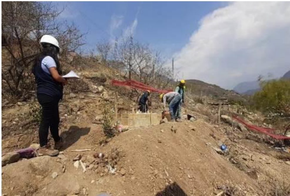
Fotografía 16: Se observa la aplicación de la carta balance en el desencofrado del sobrecimiento en M-15, ubicada en el caserío la Oroya.
