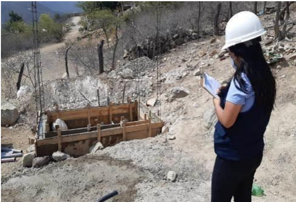
Fotografía 10: Vaciado de concreto simple en sobrecimiento en M-30, ubicada en el caserío Guayabo
