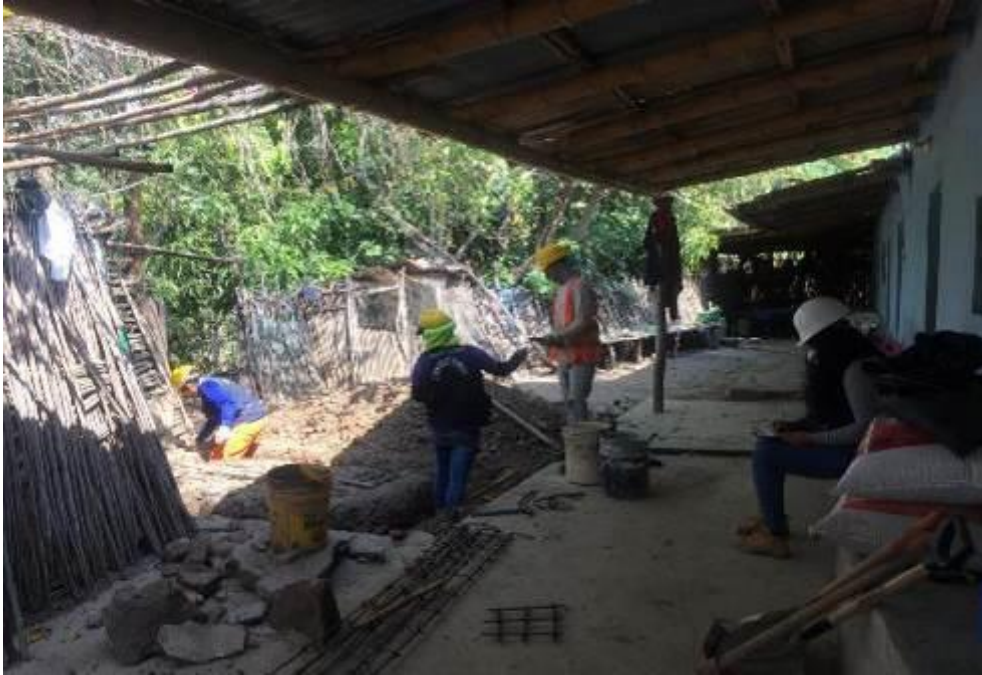
Fotografía 25: Se observa la aplicación de la carta balance en el trazo y replanteo de la cimentación de la M-40, en el caserío de Higueroes.
