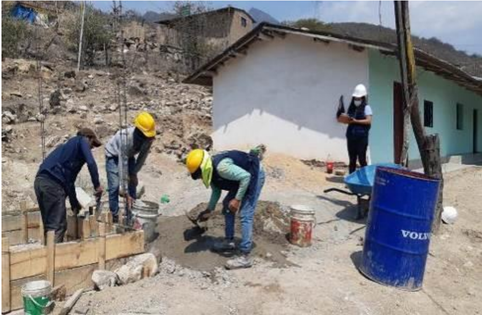
Fotografía 15: Se observa la aplicación de la carta balance en el vaciado de concreto simple en sobrecimiento en M-32, ubicada en el caserío la Oroya.
