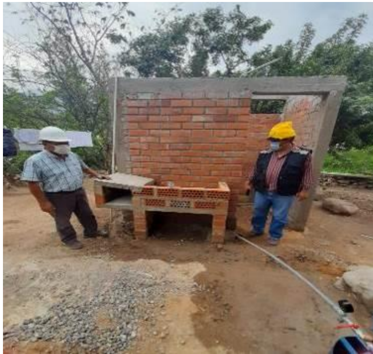
Fotografía 38: Se observa la construcción de lavadero
