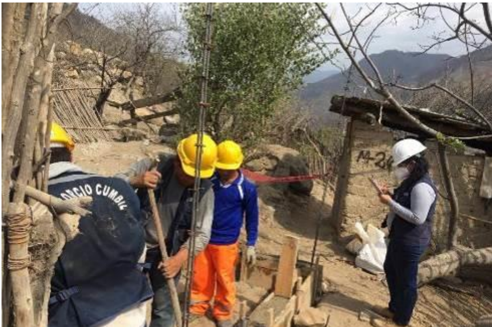
Fotografía 14: Se observa la aplicación de la carta balance en el vaciado de concreto simple en sobrecimiento en M-24, ubicada en el caserío la Oroya.
