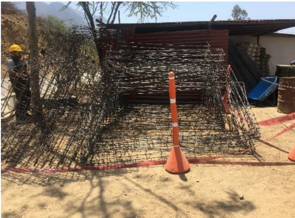
Fotografía 30: Habilidad del acero para vigas.
