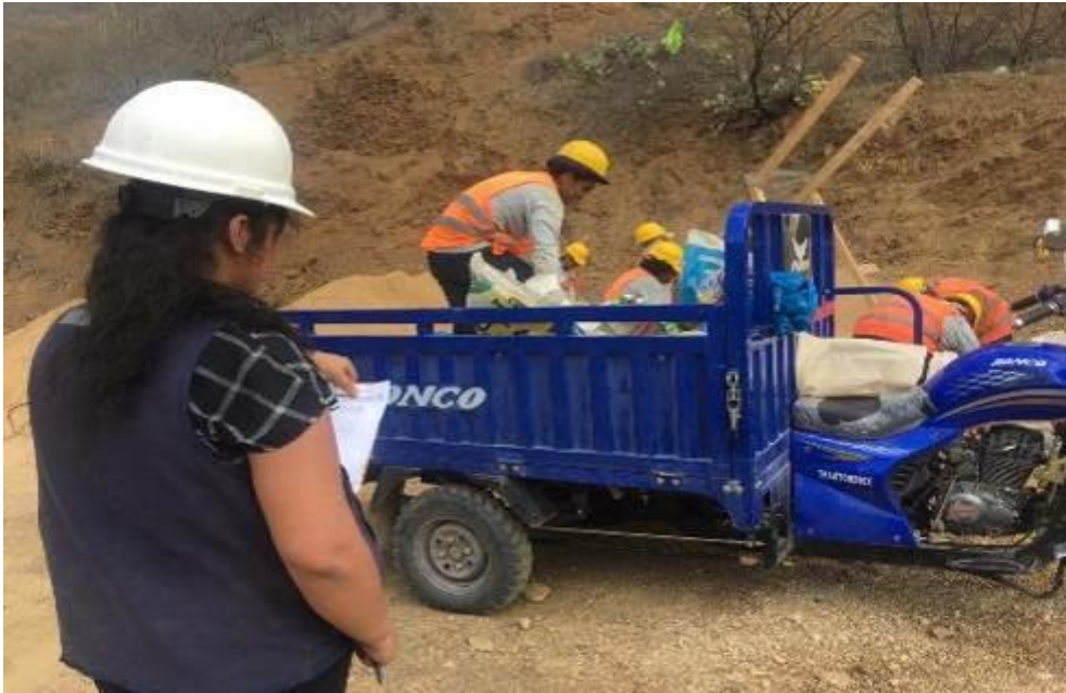
Fotografía 27: Se observa la aplicación de la carta balance en el traslado y abastecimiento de los materiales a los frentes de la obra.
