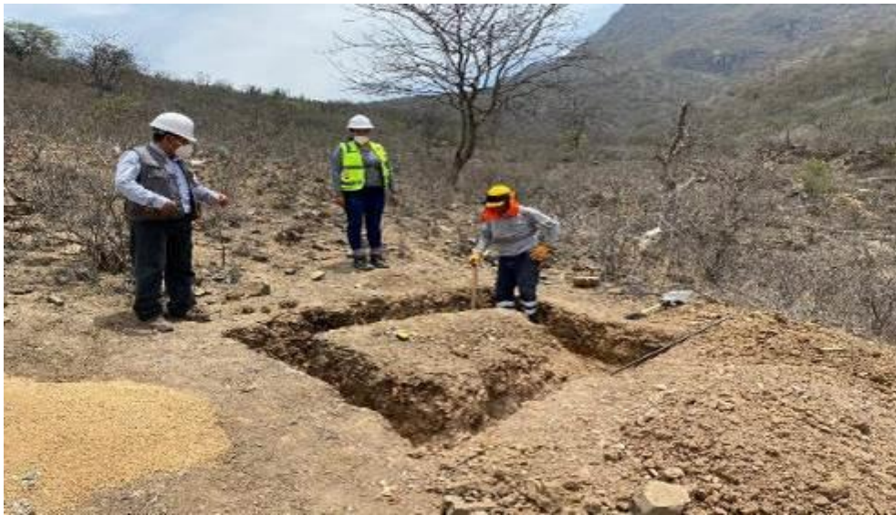
Fotografía 2: Se hizo un análisis de la situación actual de la obra, se observa la excavación manual de los cimientos de la UBS
