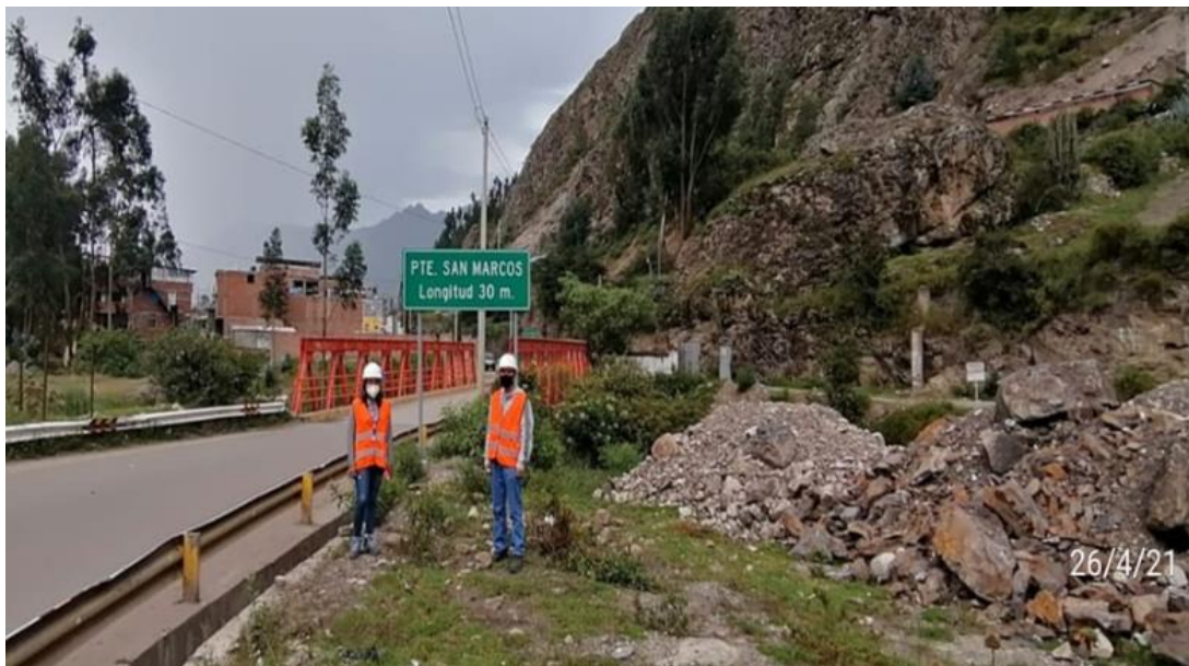
Figura 26. Puente de Distrito de San Marcos Fuente: Elaborado por los autores
