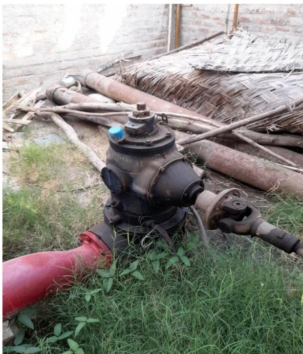
**Figura N°94:** Cabezal del pozo estacionario
