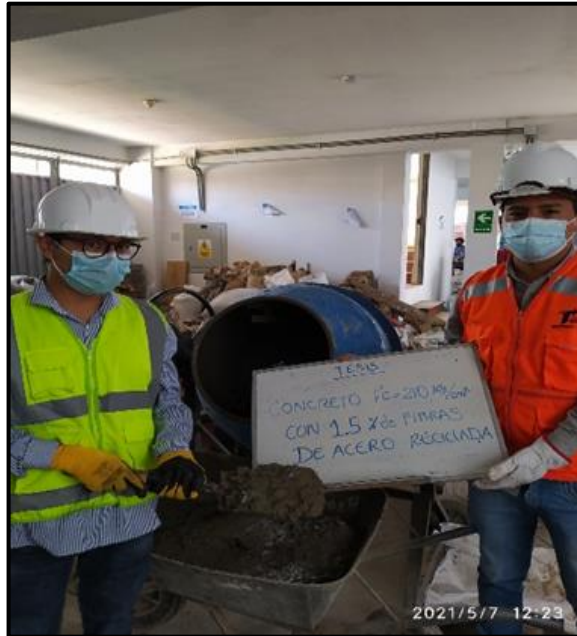
Figura 51 Elaboración del concreto reforzado con 1.5% de fibras recicladas
