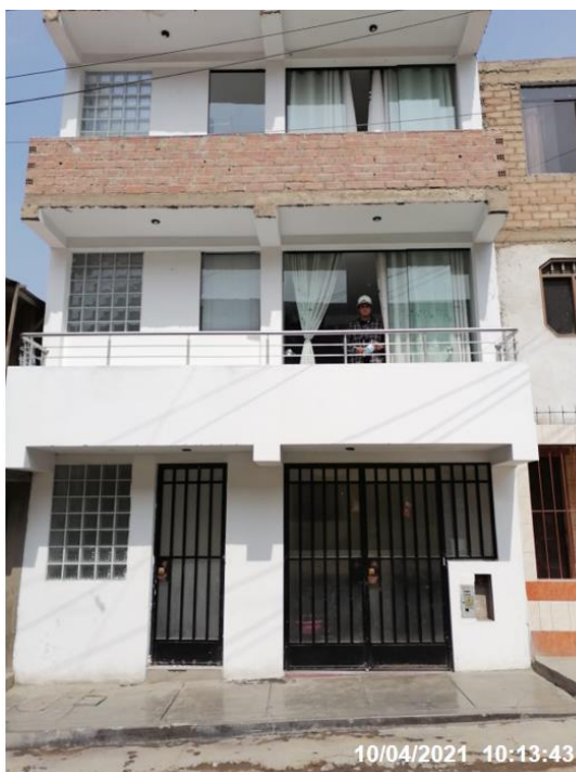
Figura 6. Fachada de la vivienda existente de tres niveles. Elaboración: El autor (2021).
