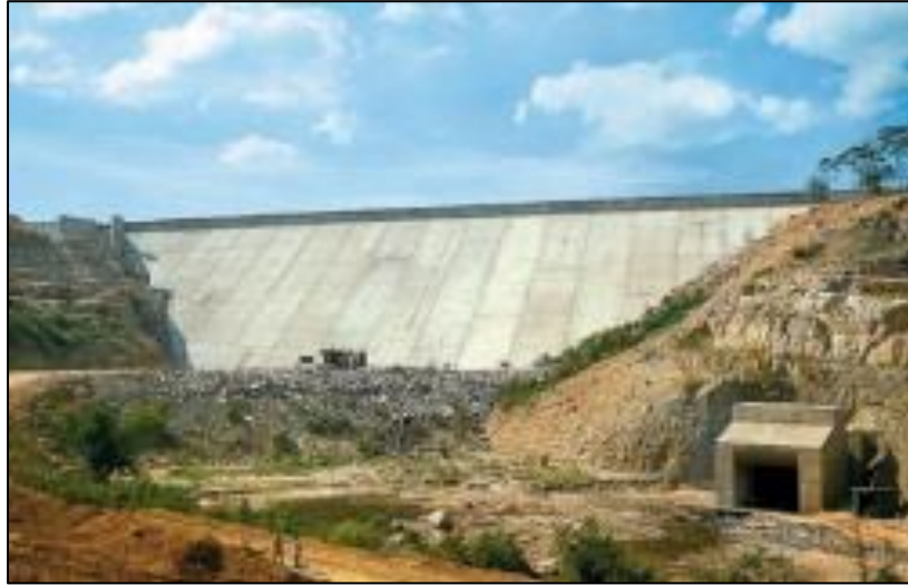
Figura 29: Presas de enrocado
