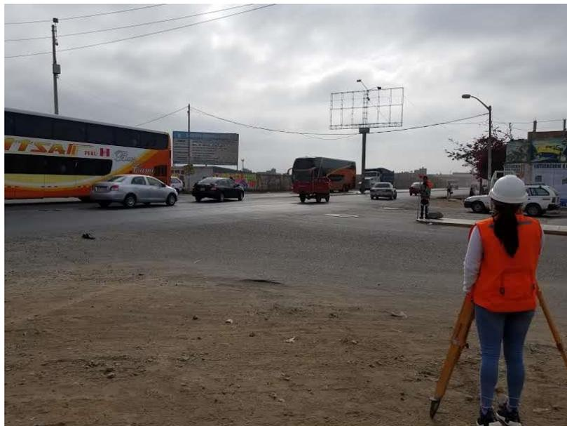
*Figura 2.* Toma de Datos del Levantamiento Topográfico de Intersección
