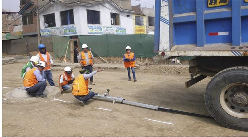
Figura 6. Evaluación estructural del pavimento Viga Benkelman.
