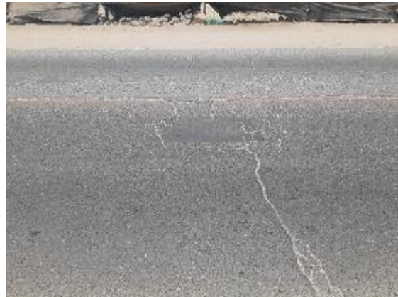
Fotografía N° 40. Parqueo Progresiva Km 1+100 – 1+150
