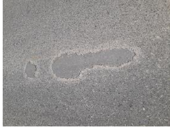
Fotografía N° 02. Parqueo Progresiva Km 0+000 – 0+050
