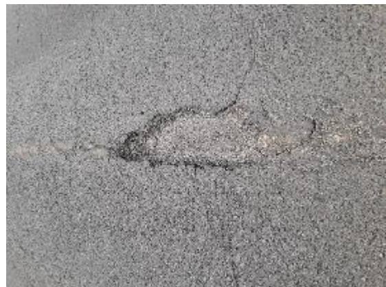
Fotografía N° 36. Hueco Progresiva Km 0+850 – 0+900
