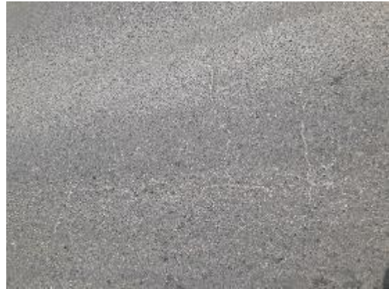
Fotografía N° 04. Grietas longitudinales y transversales Progresiva 0+000 – 0+050
