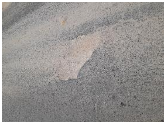
Fotografía N° 42. Hueco Progresiva Km 1+350 – 1+400
