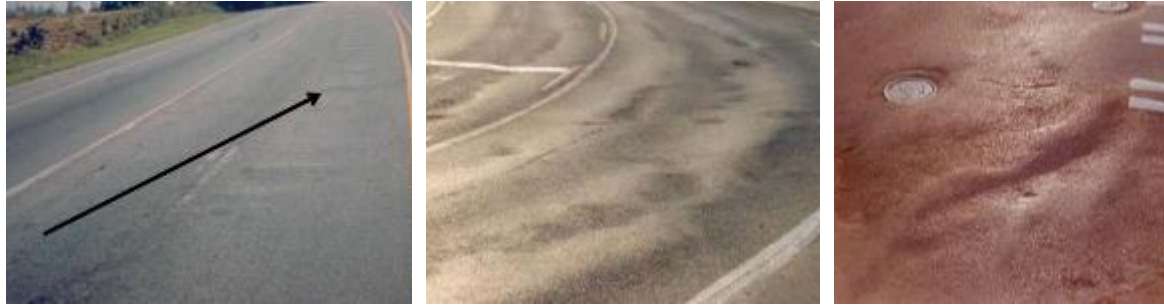
Figura 29. Desplazamiento de baja, media y alta severidad
