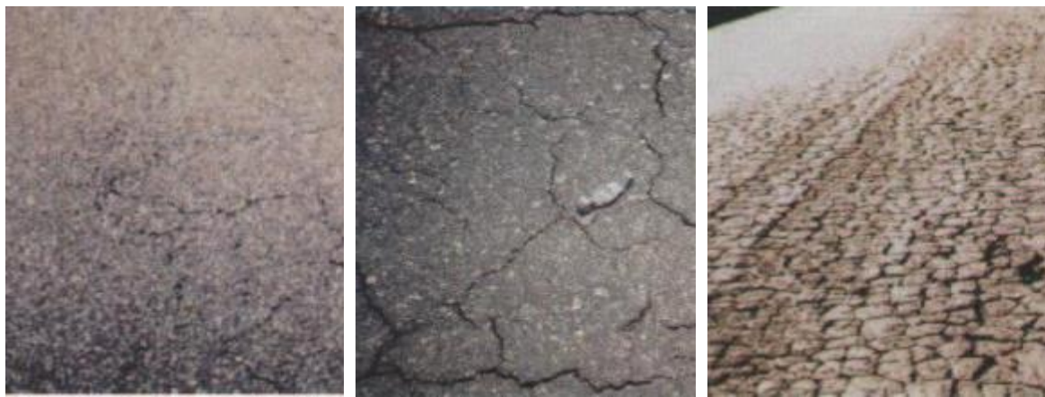
Figura 14. Piel de cocodrilo de baja, media y alta severidad
