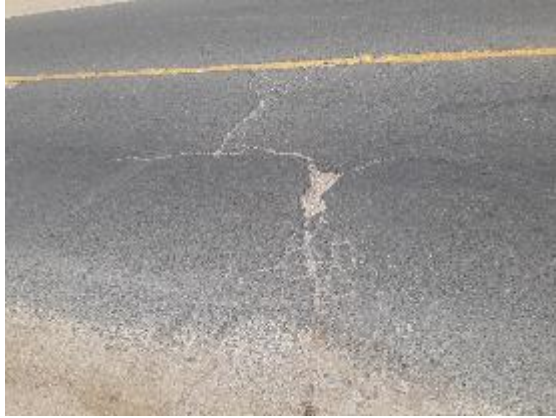
Fotografía N° 49. Hueco Progresiva Km 2+000 – 2+050
