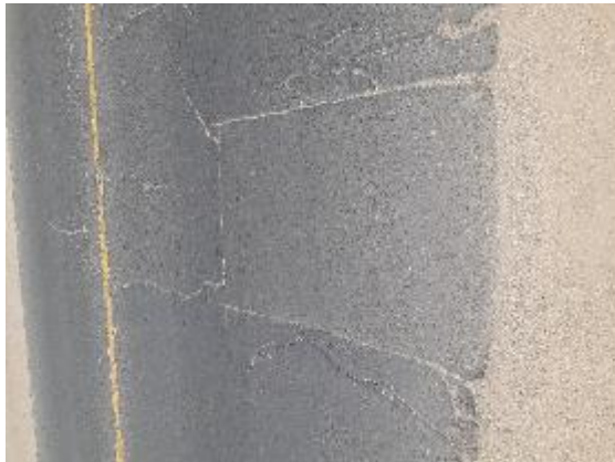
Fotografía N° 51. Parqueo Progresiva Km 2+100 – 2+150
