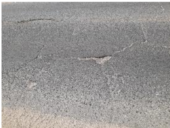
Fotografía N° 35. Hueco Progresiva Km 0+850 – 0+900
