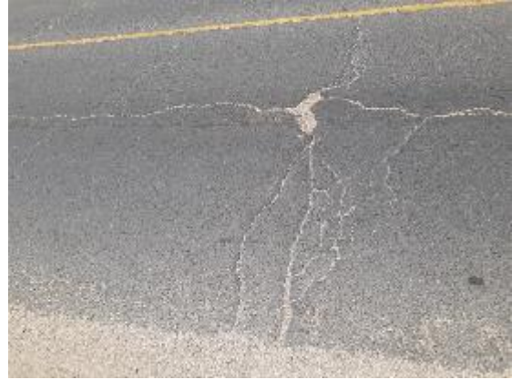
Fotografía N° 56. Huevo Progresiva Km 2+150 – 2+200
