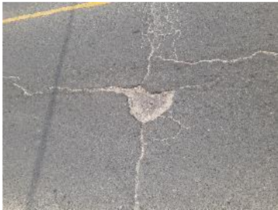
Fotografía N° 57. Huevo Progresiva Km 2+200 – 2+250
