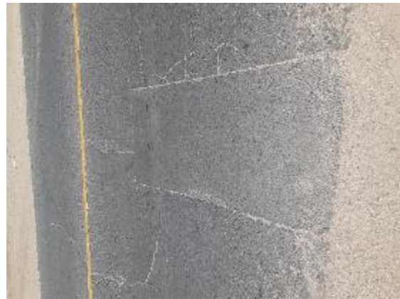
Fotografía N° 58. Parcheo Progresiva Km 2+200 – 2+250
