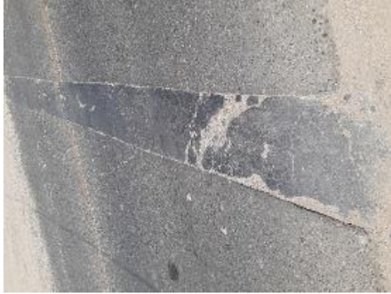
Fotografía N° 31. Parqueo Progresiva Km 0+450 – 0+500
