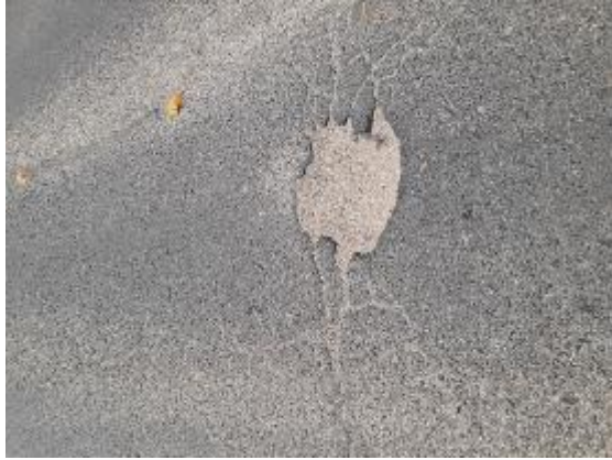
Fotografía N° 43. Hueco Progresiva Km 1+400 – 1+450
