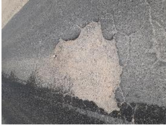
Fotografía N° 01. Hueco Progresiva Km 0+000 – 0+050
