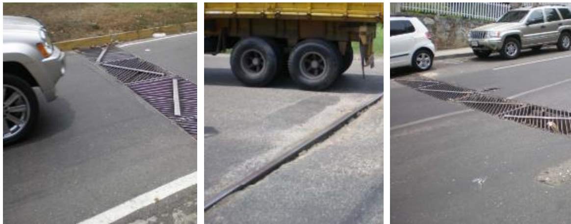
Figura 27. Cruce de vías férreas de baja, media y alta severidad
