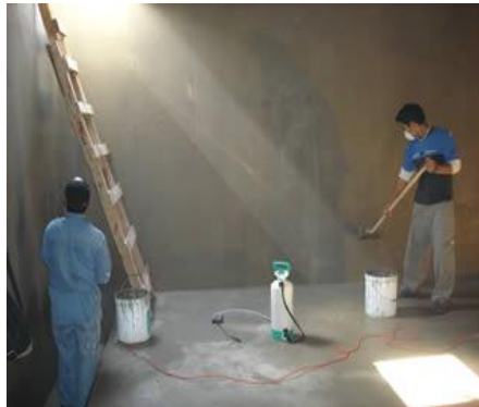
Figura 115: Impermeabilizante en cisterna Fuente: Elaboración propia
