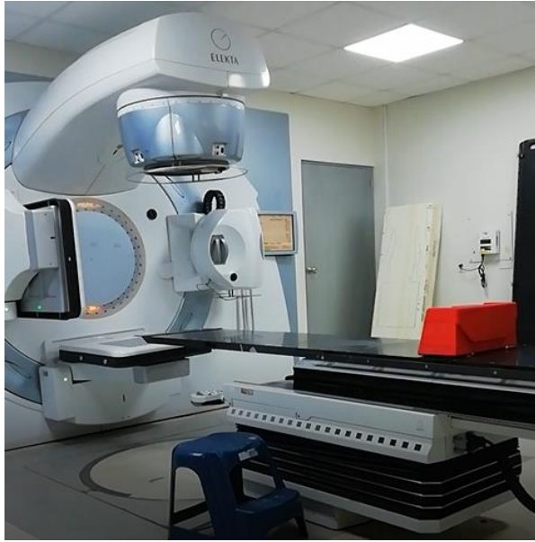
Figura 59. Se observa el bunker de radioterapia. Fuente: Trabajo de Campo.
