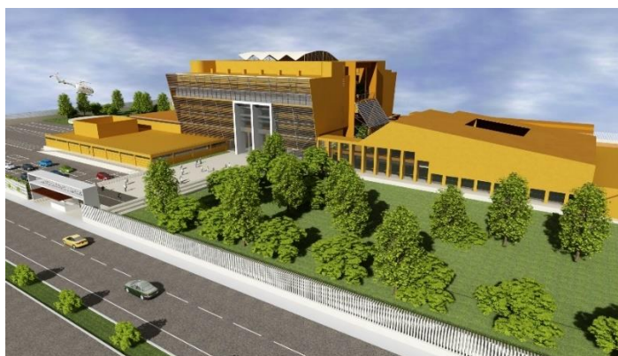
Figura 16. Vista actual del Hospital Regional.
