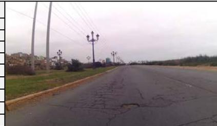
Anexo 25: Cálculo del Índice de Condición del Pavimento TRAMO-23.
