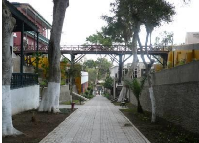
Figura 20. Puente de los Suspiros año 2011. (Fuente propia)
