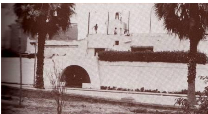
Figura 11. Casa de Mario Vargas Llosa al momento de su demolición. (Recuperado de Bulnes, 1996, p. 25)
