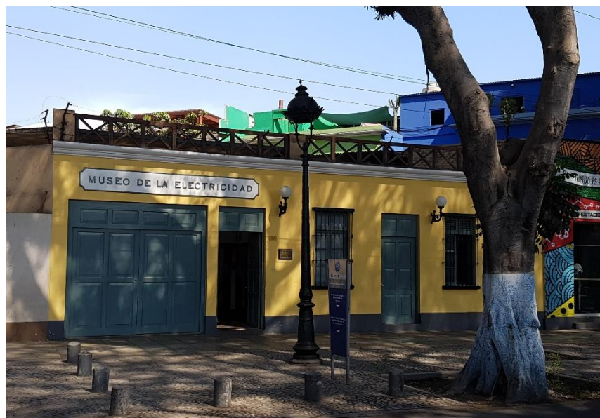
Figura 67. Museo de la Electricidad, año 2017. (Fuente propia)
