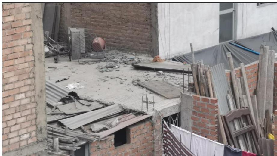
**Figura 92.** Cubierta no apoyada a la losa aligerada – vivienda 4
