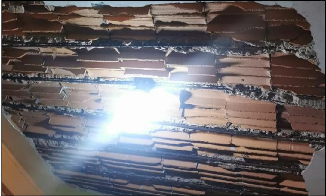
**Figura 99.** Estado de componentes no estructurales – vivienda 13
