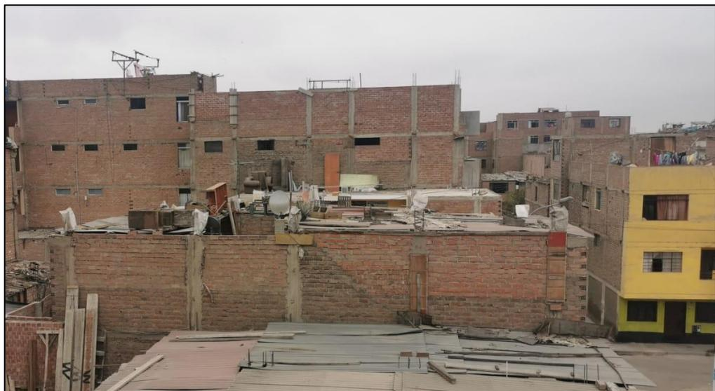
**Figura 72.** Mala conexión de diafragmas con muro portante – vivienda 13
