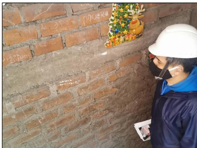
**Figura 41.** Muro portante amarre tipo cajón – vivienda 9
