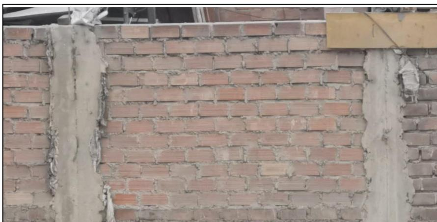
**Figura 40.** Muro portante no ligado – vivienda14
