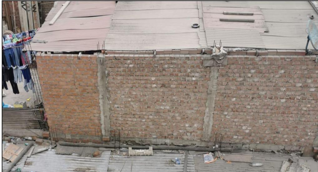
**Figura 71.** Mala conexión de diafragmas con muro portante – vivienda 14
