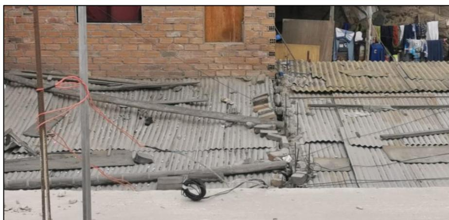
**Figura 93.** Cubierta inestable – vivienda 6
