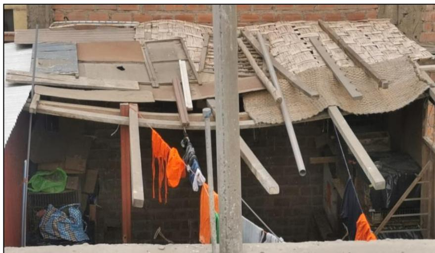
**Figura 70.** Deformación y mala conexión de diafragmas – vivienda 16
