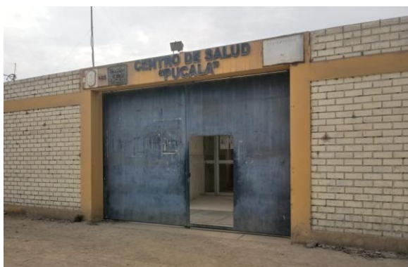
Figura N°13.- Fachada C.S. Pucalá
