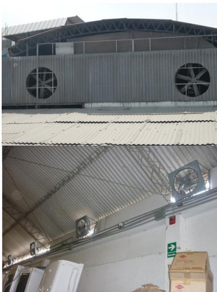
**Imagen3.31 Sistema de ventilación del taller**
