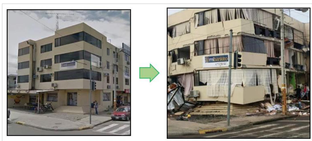
Figura 9. Estructura colapsada por falla de piso blando Fuente: Adaptado de Páez, Zabala & Rodríguez (2017).
