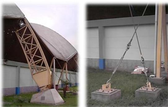
**Foto N°49-50: Elementos estructurales de la cobertura del coliseo**
