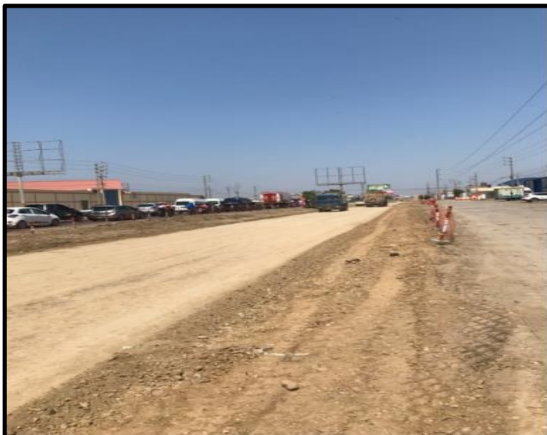
FOTOGRAFIA 2: Trabajos en Obra
