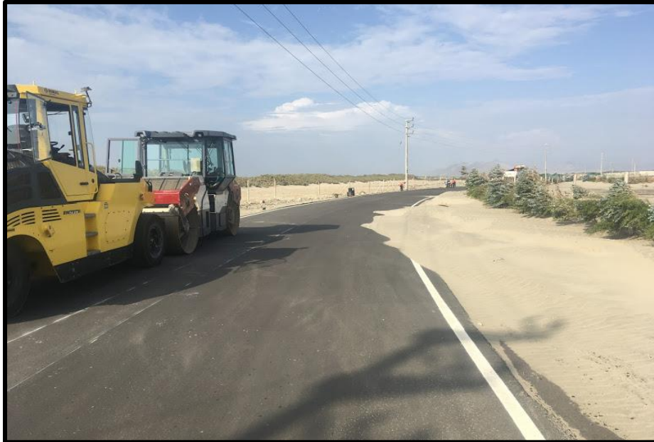
FOTOGRAFIA 15: Perfilado y Compacto final
