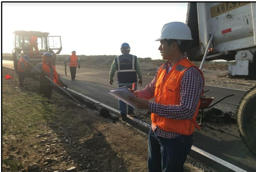
FIGURA 16: Toma de datos en campo
