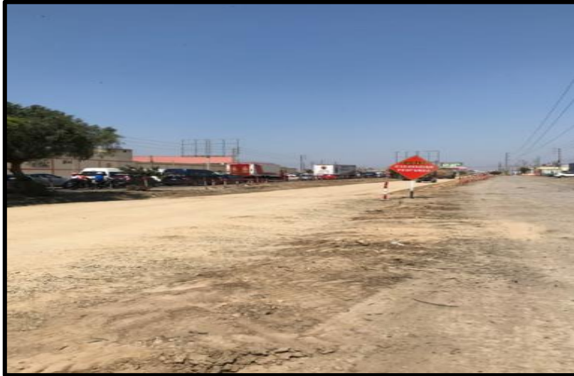
FOTOGRAFIA 1: Vía no Pavimentada
