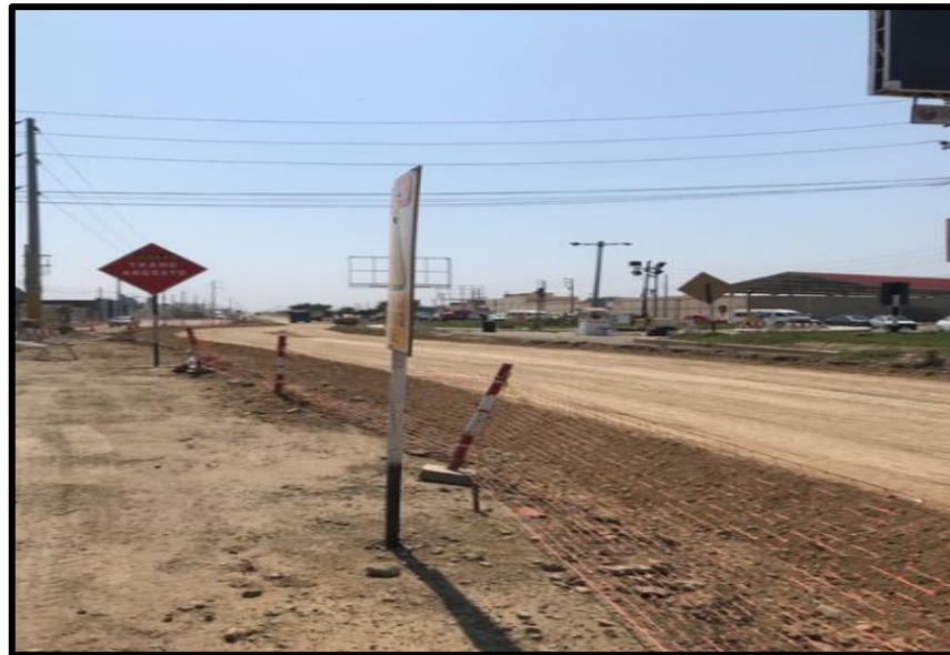
FOTOGRAFIA 4: Excavación y Movimiento de Tierras
