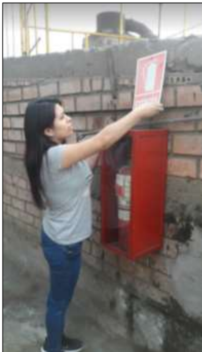
Figura 160: Tesista colocando la señalización
