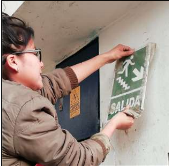
Figura 159: Tesista colocando la señalización
