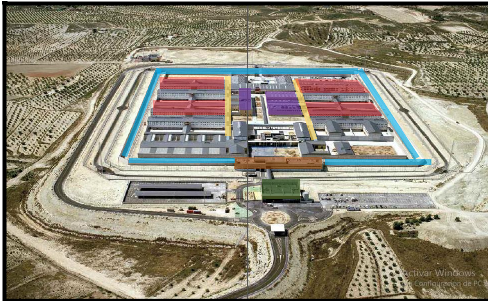
Figura N°6: Vista a vuelo de pájaro del Centro Penitenciario Murcia II
