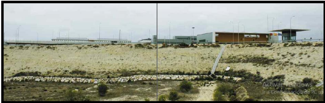
Figura N°5: Vista exterior del Centro Penitenciario Murcia II
