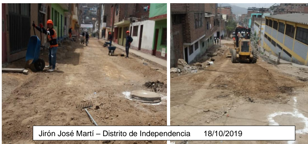
Figura 61: Conformación de veredas – Corte a nivel de sub-rasante
