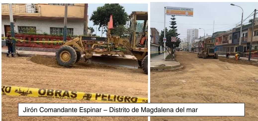
Figura 67: Conformación y compactación a nivel de base
