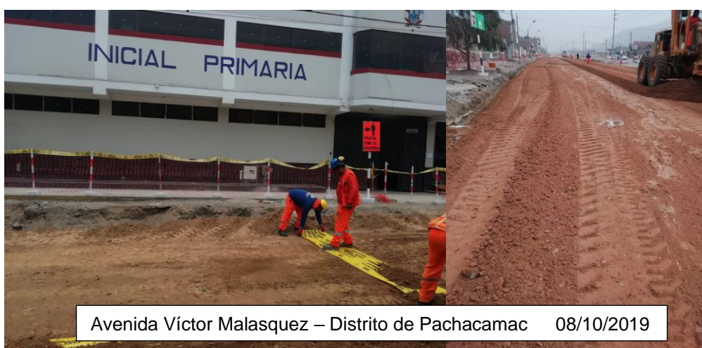
Figura 58: Conformación y compactación a nivel de base
