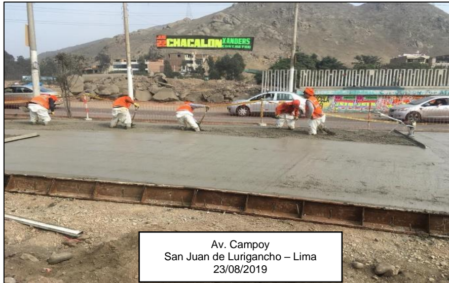
Figura 17: Conformación del pavimento rígido
