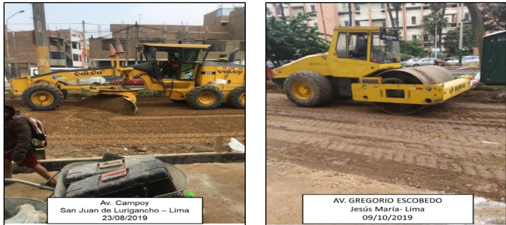
Figura 20: Fotografías de la etapa de conformación y compactación a nivel de base
