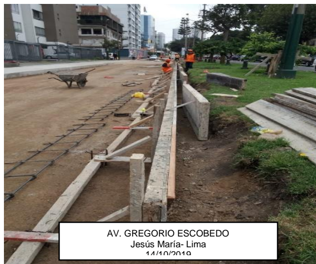
Figura 22: Encofrado de vereda
