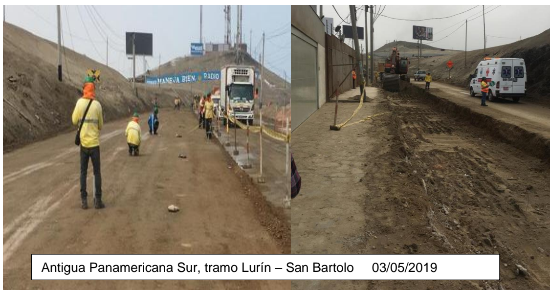
Figura 52: Trazo y replanteo – Excavación a nivel de sub-rasante
