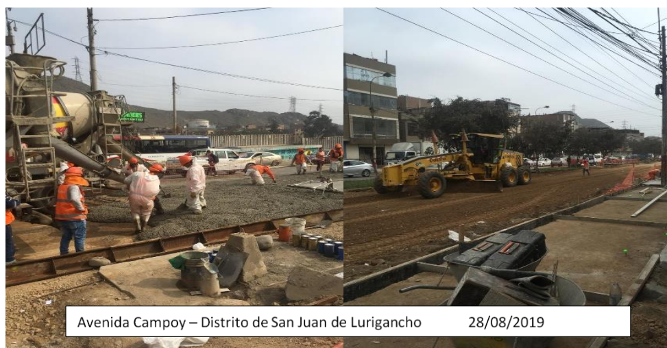
Figura 64: Concreto rígido – Conformación de sub-base
