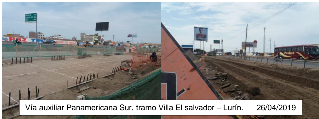
Figura 49: Movimiento de tierra
