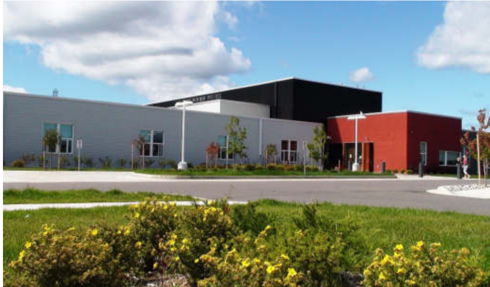
Figura N°21: Vista exterior del Centro de Tratamiento de Adicciones Hermana Margaret Smith
