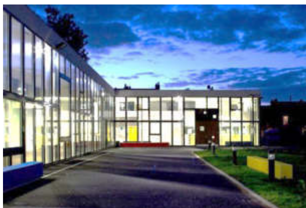
Figura N°43: Fachada del Centro de rehabilitación Spring Gardens
