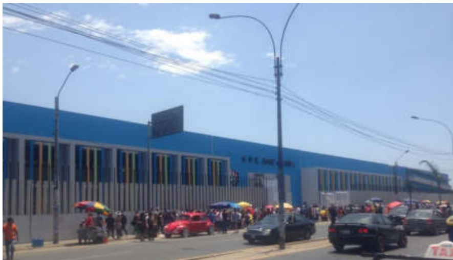
Figura 7: Ingreso Colegio José Granda. Elaboración: el autor
