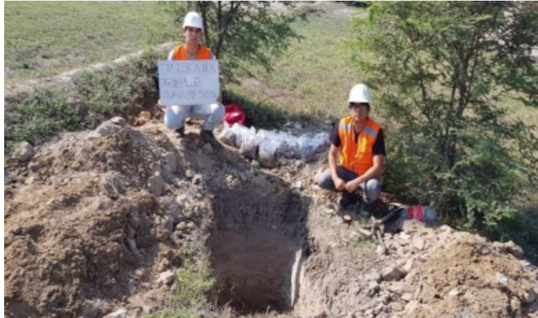
Figura 37. Calicata 07 – Pueblo Nuevo. Fuente: Elaborado por los autores.
