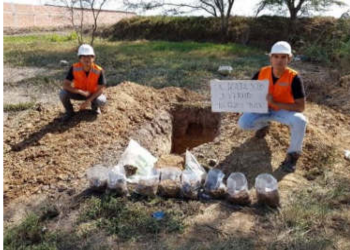
Figura 33. Calicata 03 – La Victoria. Fuente: Elaborado por los autores.
