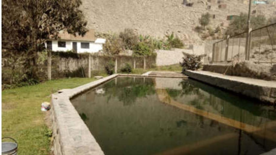
**Figura 35.** Vista de cámara de floculación
