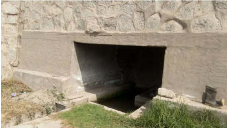
**Figura 27.** Cámara de captación de agua de río
