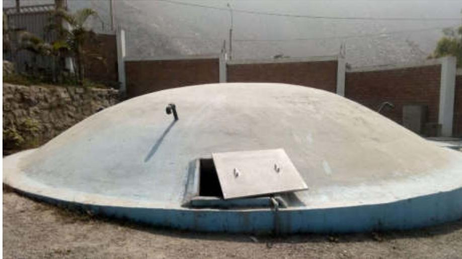
**Figura 41.** Tanque de almacenamiento
