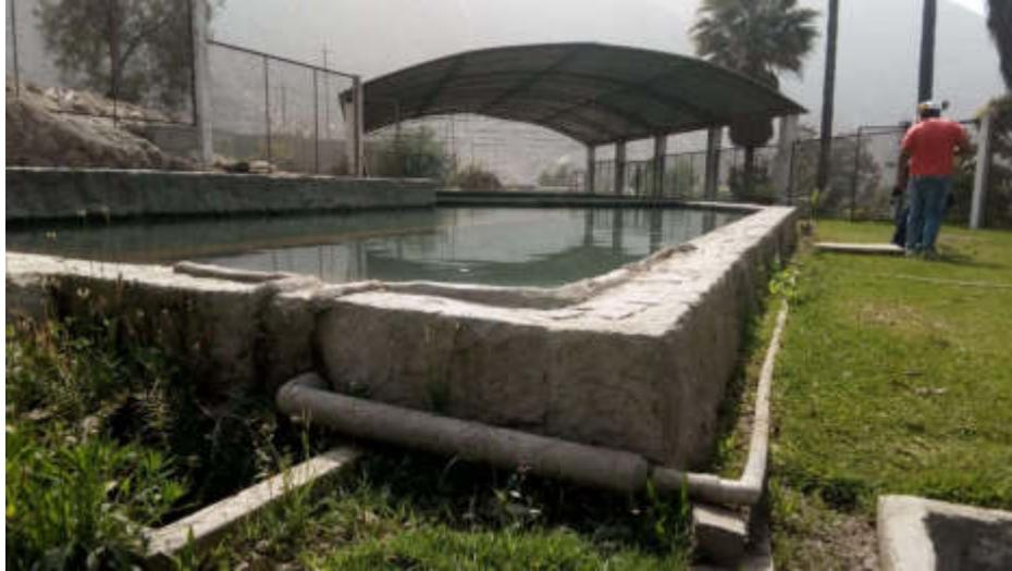
**Figura 33.** Ingreso a cámara de floculación
