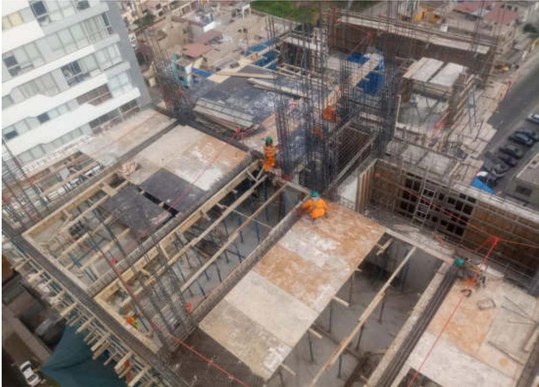
Fotografía 005: Colocación de encofrado en losa de los sectores 1 y 2 por la empresa contratista H C edificaciones.
