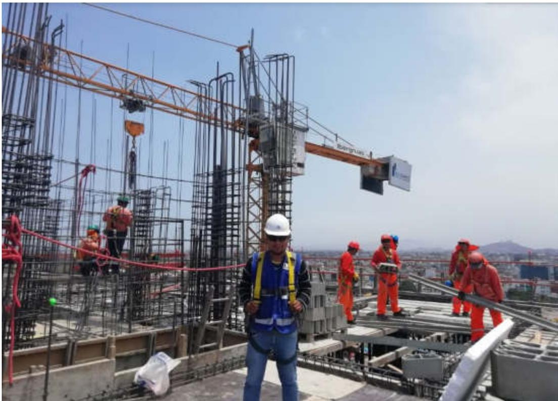
Fotografía 010: Colocación de viguetas y bovedillas con supervisión del tesista.
