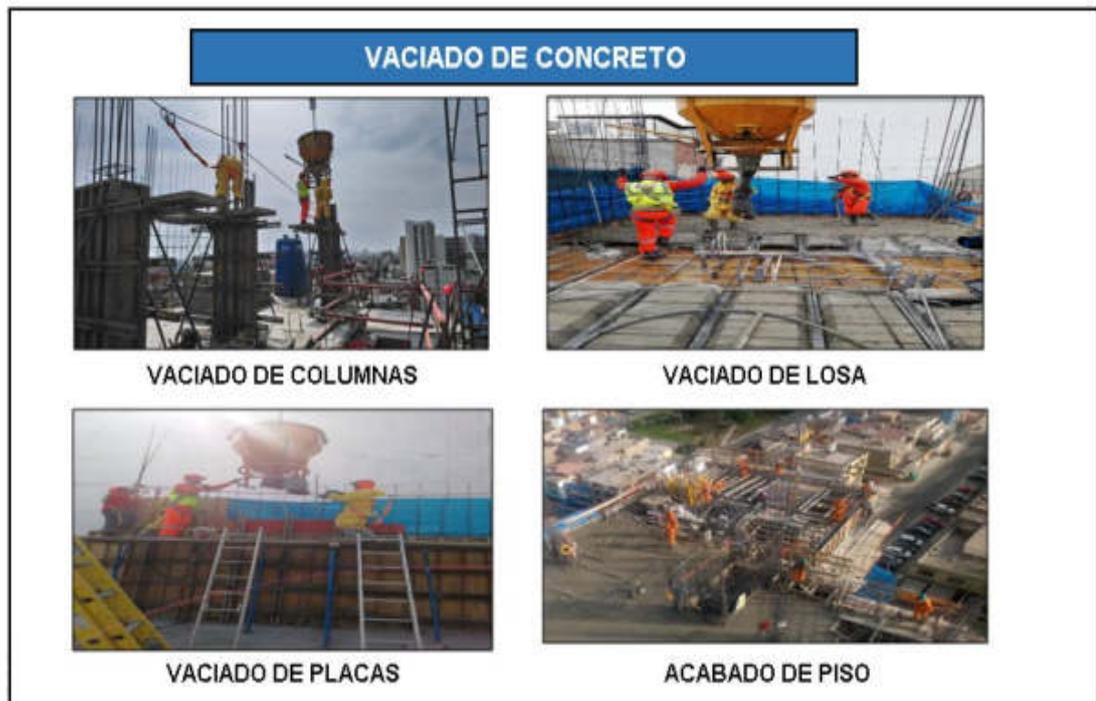
Figura 18. Vaciado de concreto.
