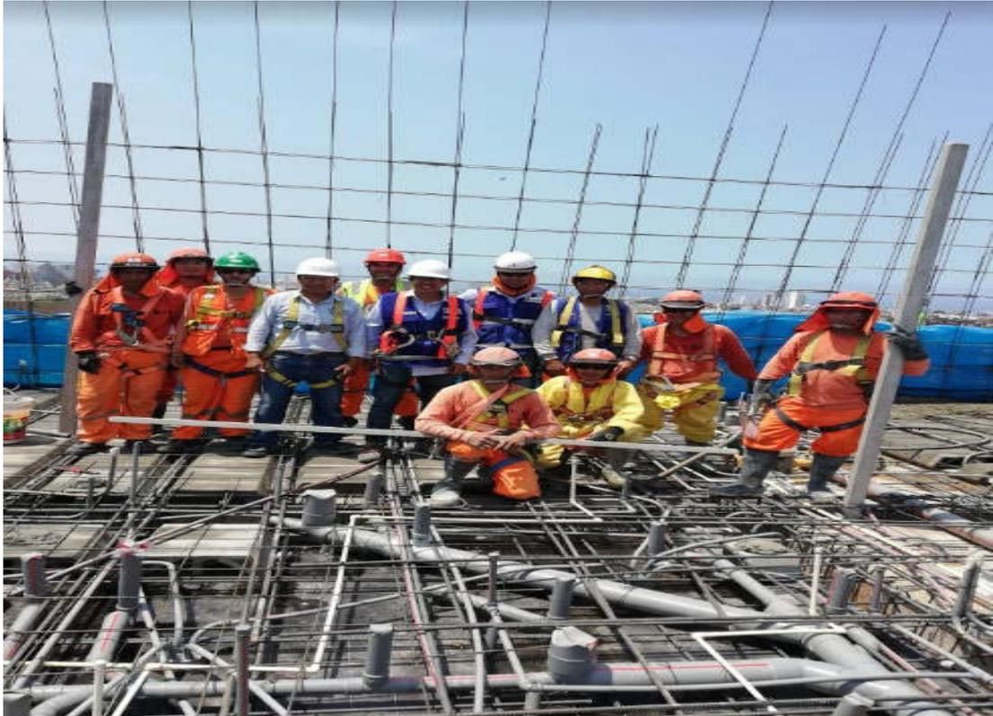
Fotografía 011: Supervisión de losa por el Ingeniero Residente junto al maestro de obra y el tesista acompañando de los capataces de acero encofrado y acabado de piso antes de iniciar el vaciado.
