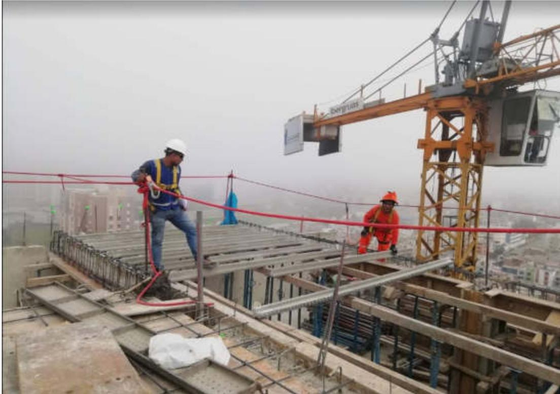
Fotografía 009: Colocación de viguetas en la Azotea con supervisión del tesista.
