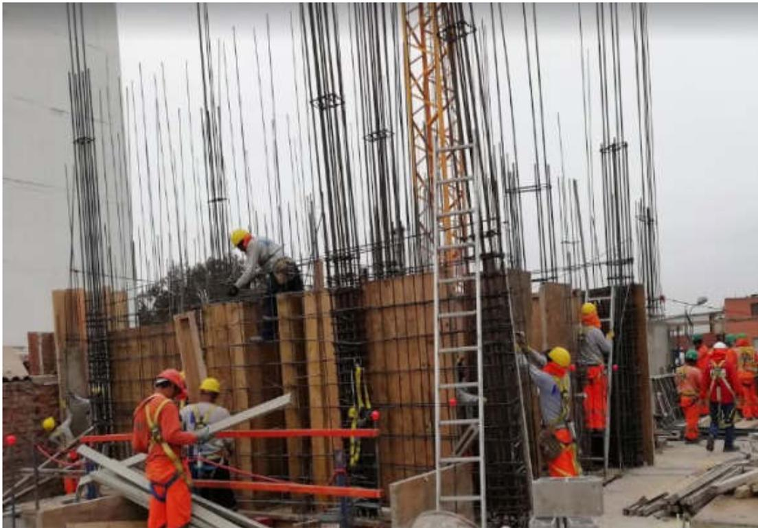
Fotografía 003: Colocación de encofrado en placas por la empresa contratista H C edificaciones.
