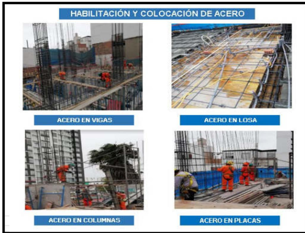
Figura 17. Habilitación y colocación de acero en el casco.
