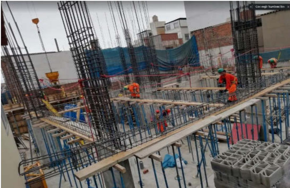
Fotografía 001: Colocación de acero en vigas por la empresa contratista 2 A ingenieros
