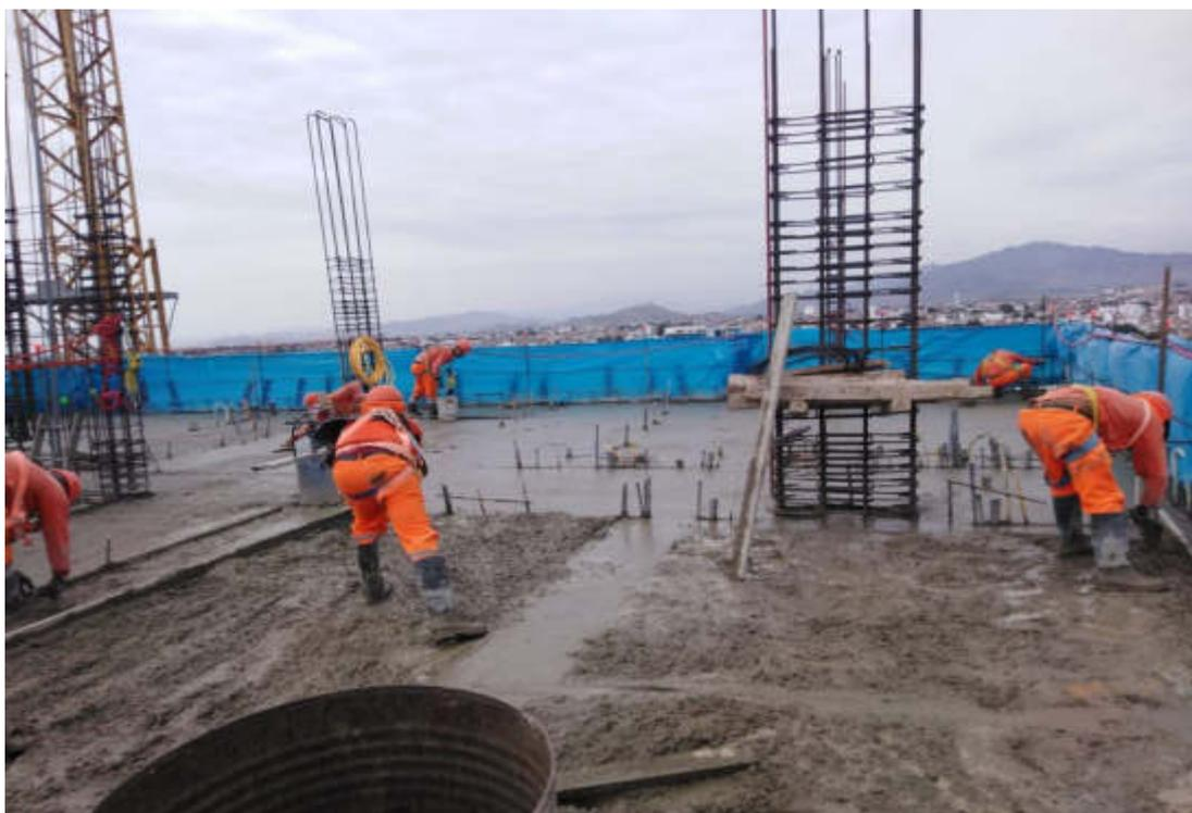
Fotografía 007: Operarios albañiles realizando la actividad de pulido de piso acabado.
