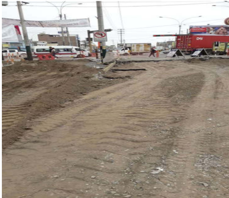
Excavación y eliminación
