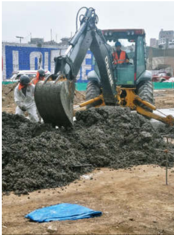
Esparcimiento de concreto con excavadora
