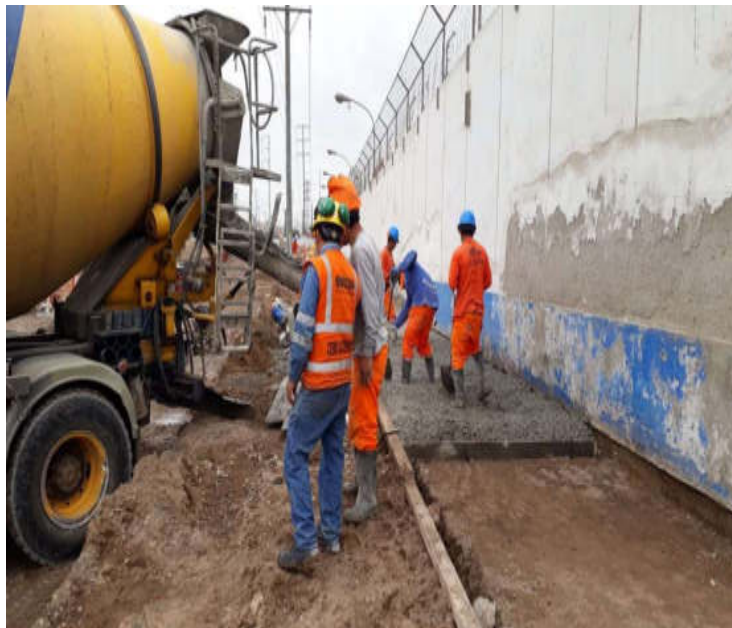
Vaciado de concreto para veredas
