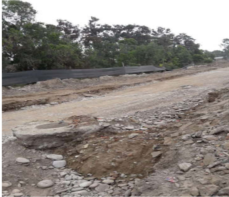
Conformación de capa de mejoramiento
