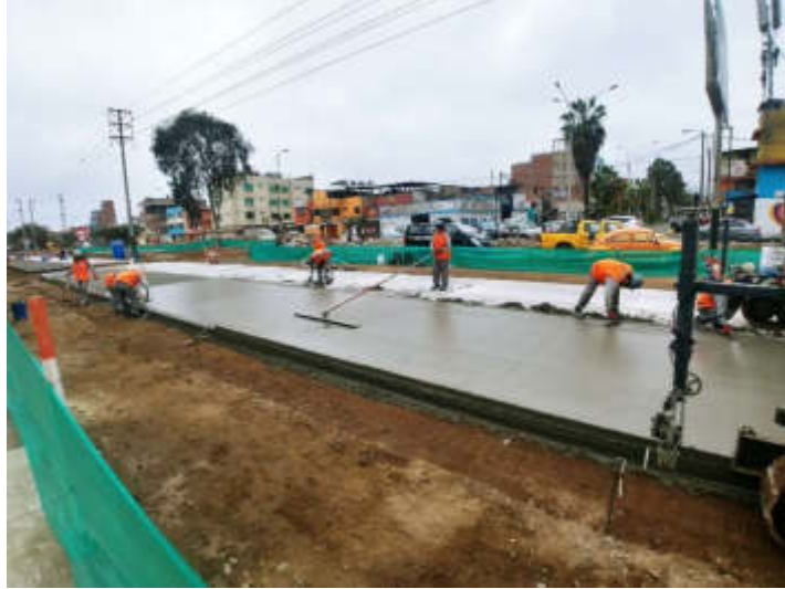
Figura 28 Acabado de pavimento rígido
