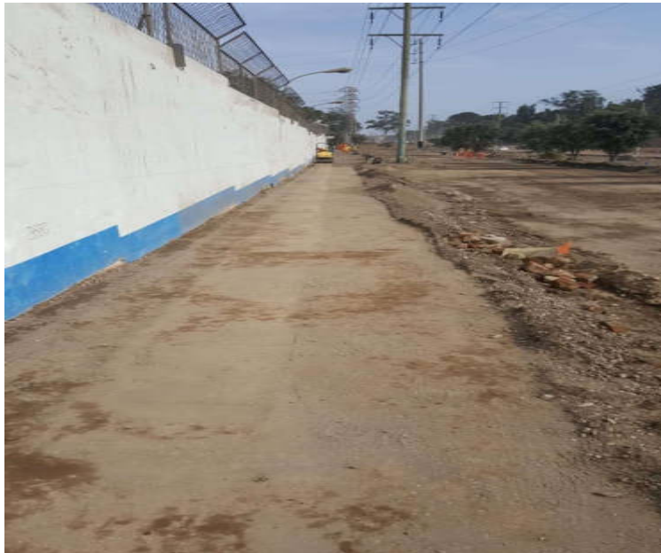
Conformación de sub base
