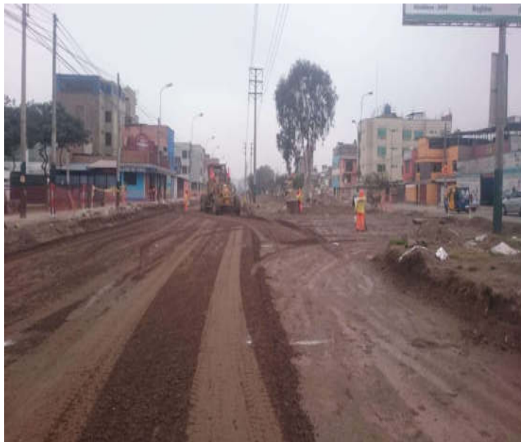
Conformación de sub base
