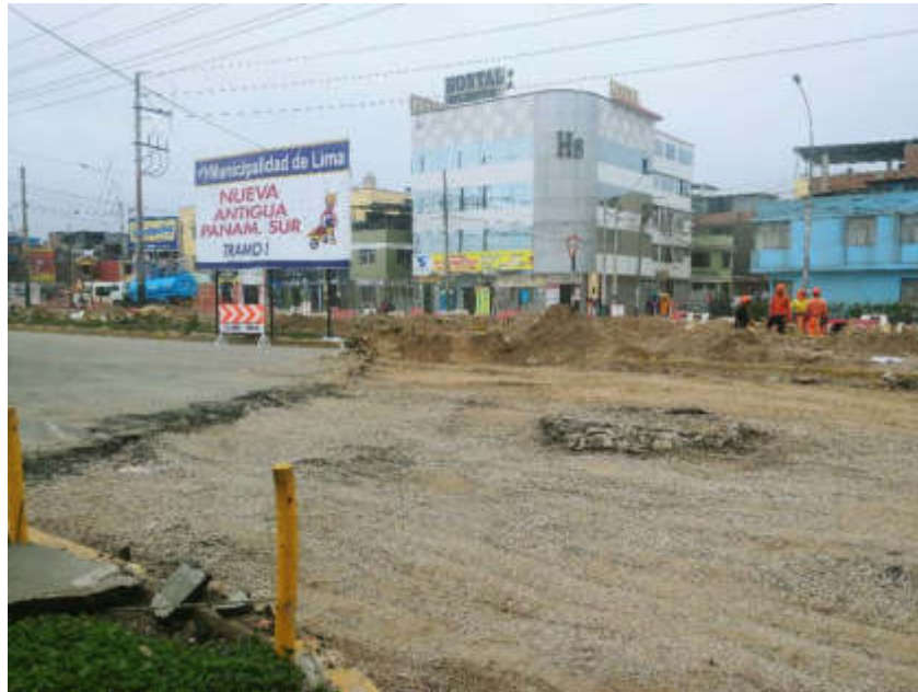
Excavación y eliminación de pavimento flexible
