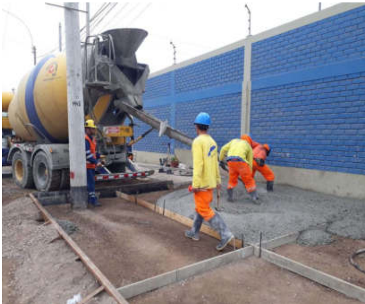
Vaciado de concreto
