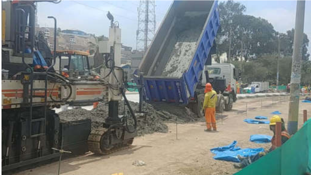
Vaciado de concreto
