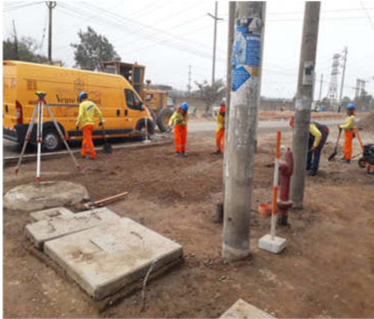
Conformación de sub base para vereda
