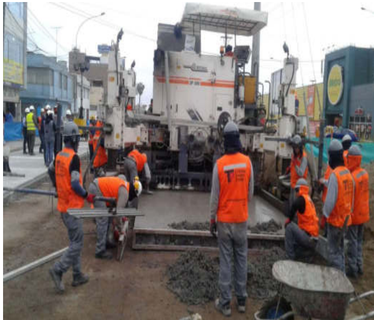
Vaciado de concreto
