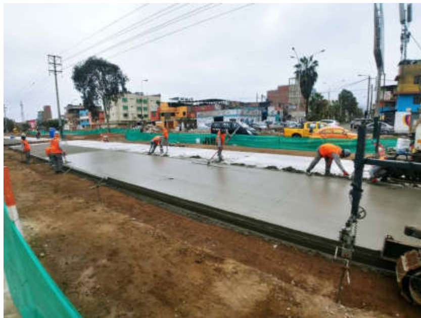
Acabado de pavimento
