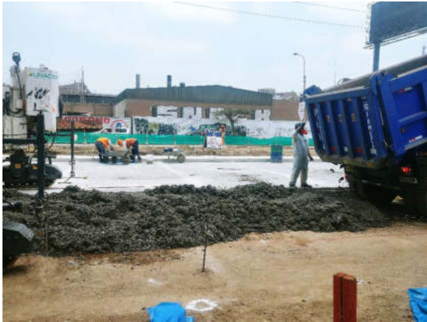
Vaciado de concreto para pavimento
