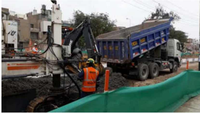
Figura 24 Vaciado de concreto para pavimento rígido
