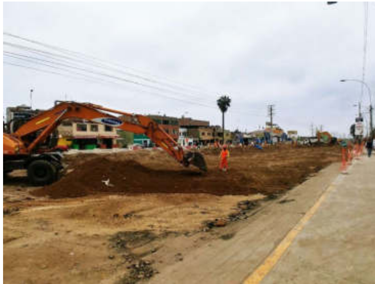
Figura 20. Excavación y eliminación
