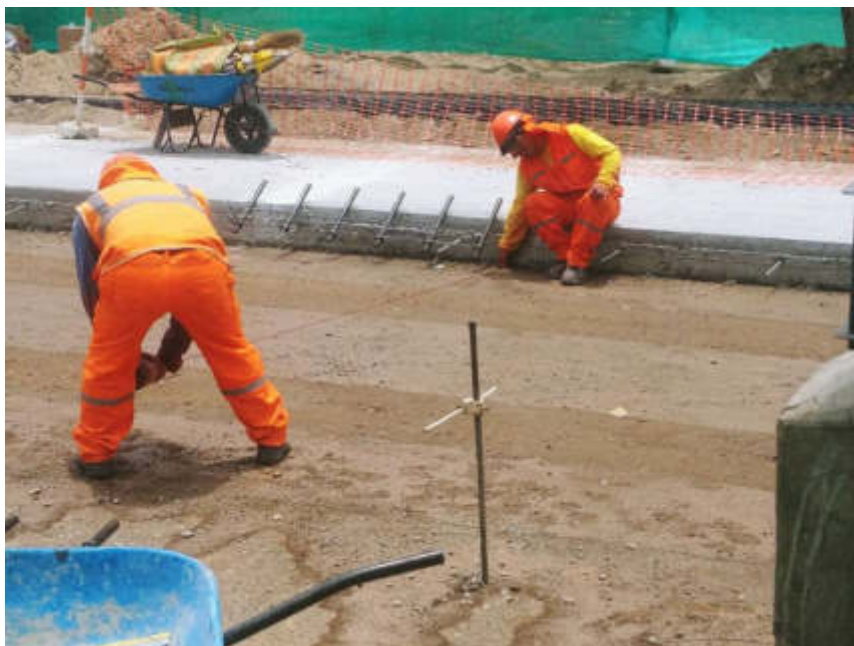
Trazo para colocación de dowells
