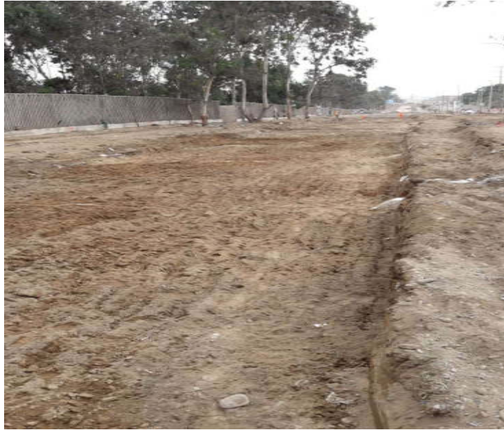
Excavación y eliminación
