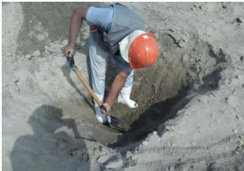
Identificación de calicatas y comienzo de excavación
