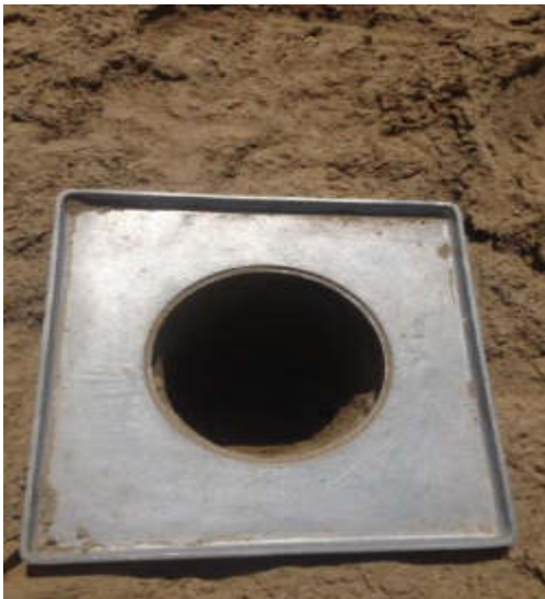
Abertura del hueco
