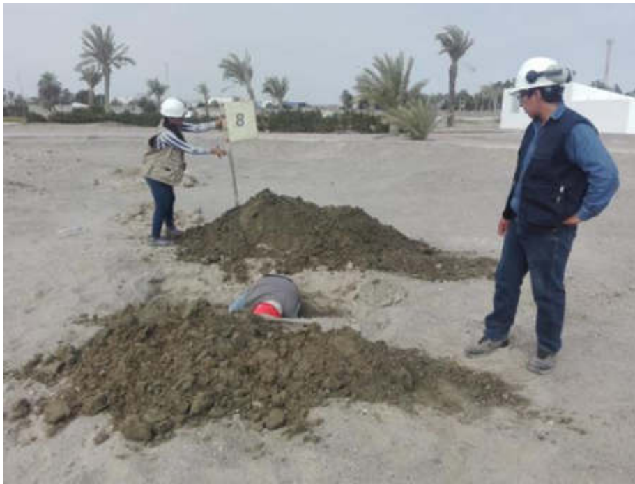
Excavación de Calicata N°8
