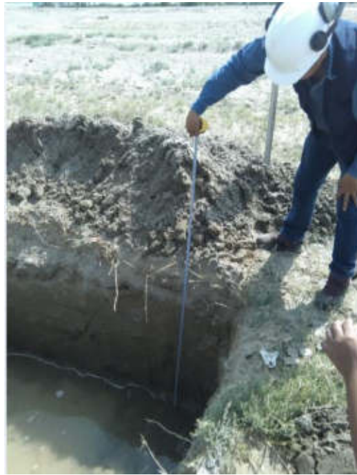
Medición de nivel freático
