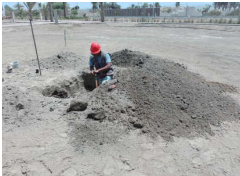
Excavación Calicata N°1
