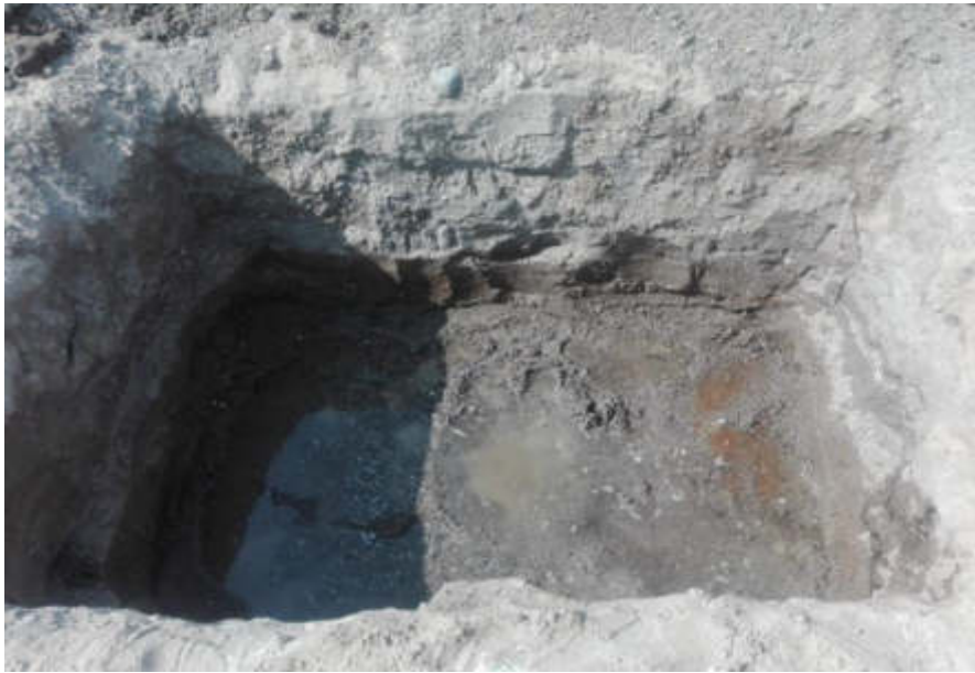
Excavación de calicata hasta encontrar napa freática
