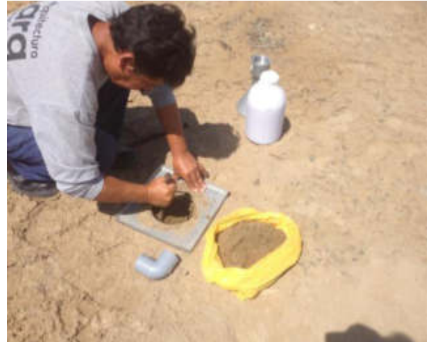
Excavación del hueco
