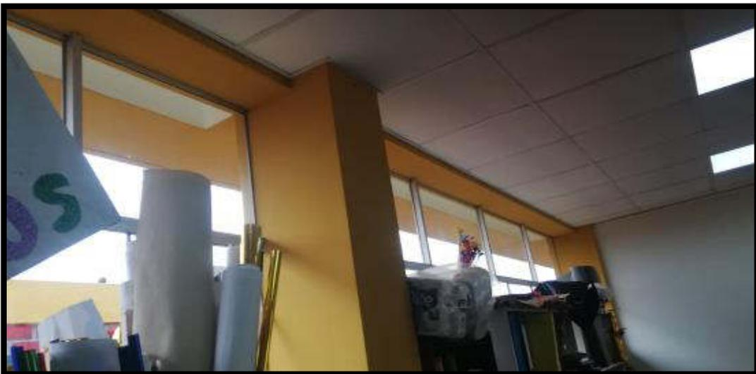
Figura 41. Buena conexión del diafragma con los muros en el módulo II
