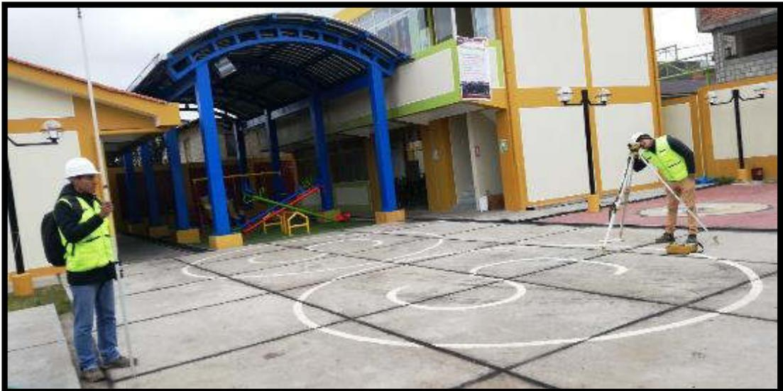
Figura 40. Medición de la pendiente del módulo II
