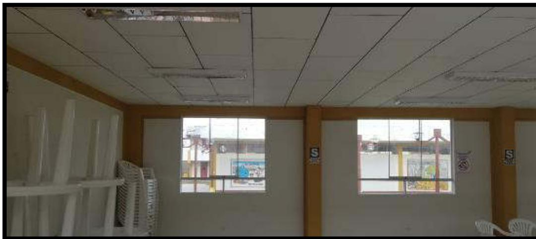
Figura 186. Buena conexión entre el diafragma y los muros del módulo VI
