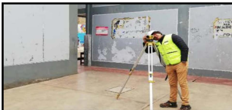
Figura 230. Medición de la pendiente del módulo III
