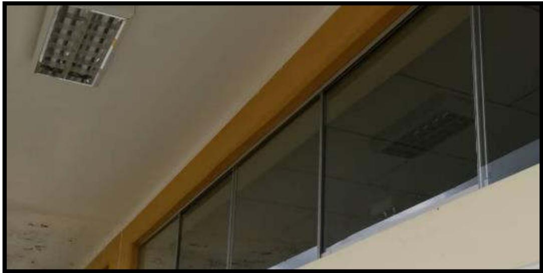
Figura 175. Buena conexión entre el diafragma y los muros del módulo V
