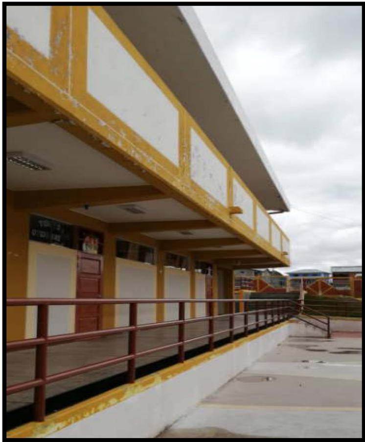
Figura 136. Voladizos y parapetos del módulo I
