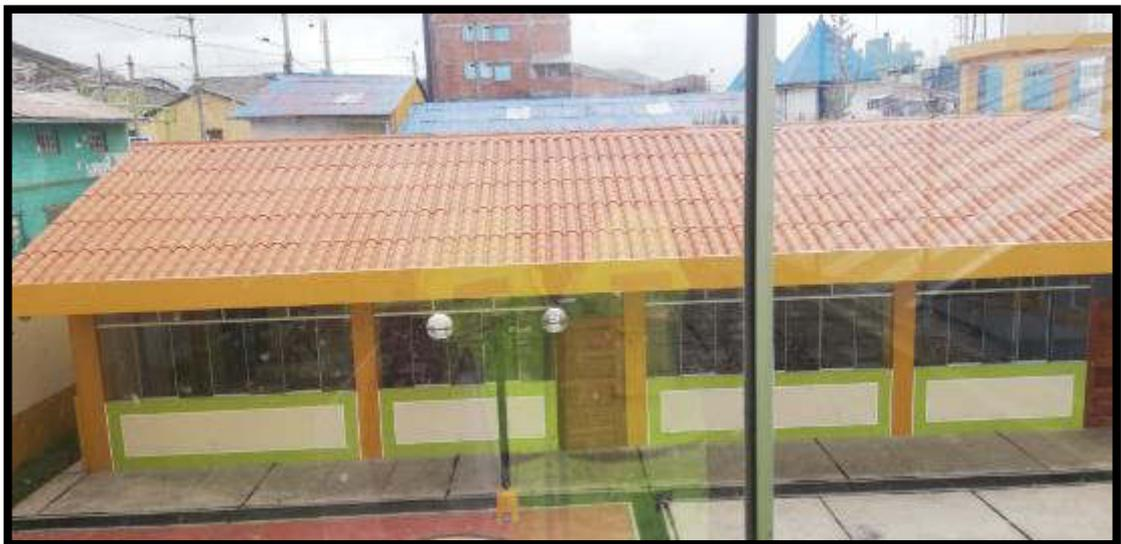
Figura 34. Cubierta del techo del módulo I
