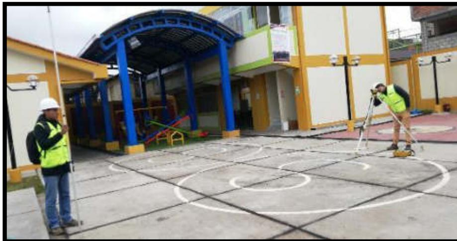
Figura 51. Cálculo de la pendiente en el módulo III
