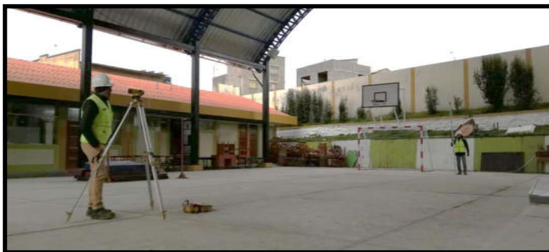
Figura 96. Cálculo de la pendiente del módulo II
