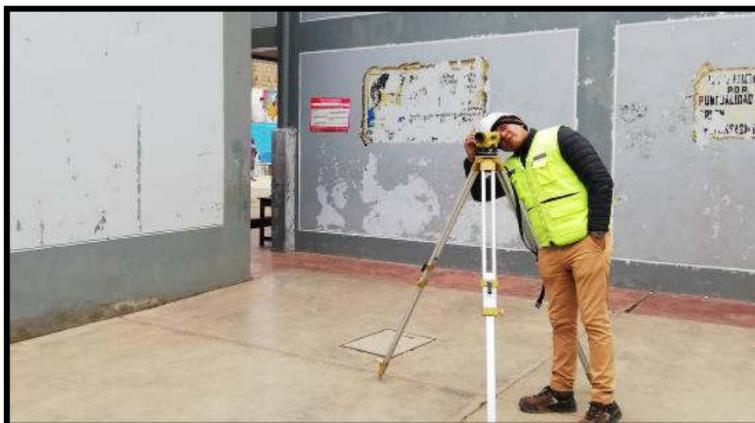
Figura 208. Medición de la pendiente del módulo I
