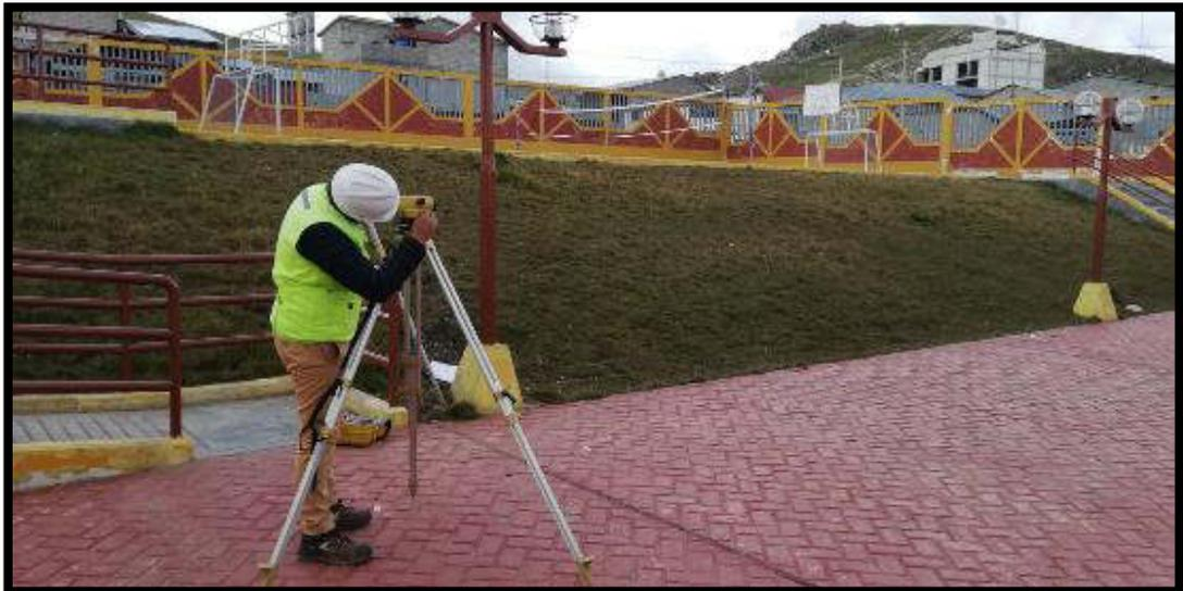
Figura 141. Medición de la pendiente del módulo II
