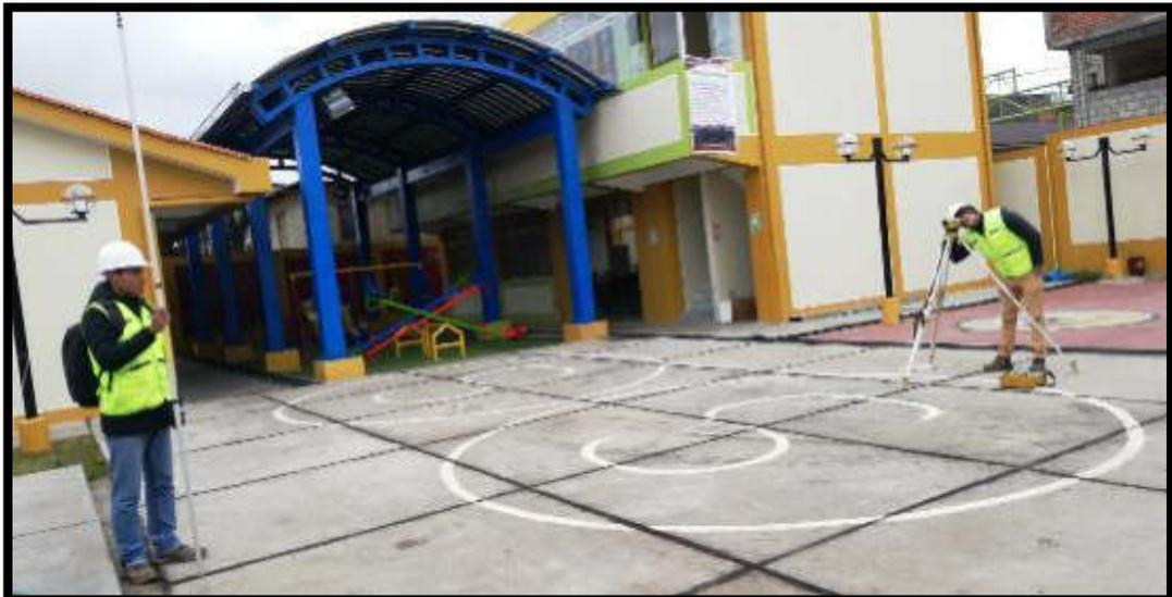
Figura 73. Cálculo de la pendiente del módulo V
