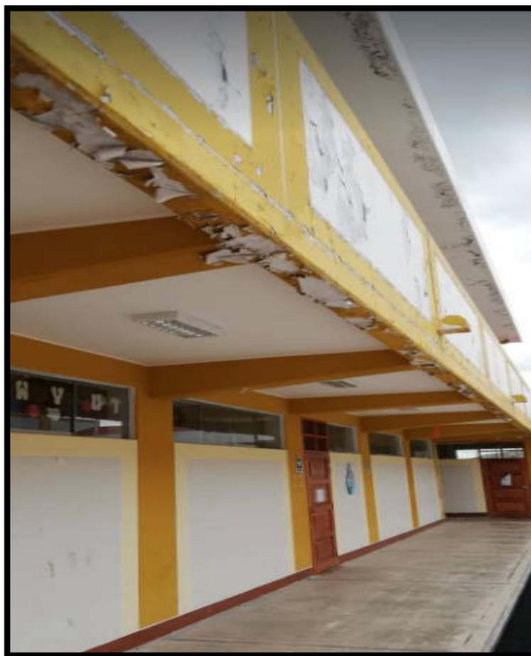
Figura 158. Voladizos y parapetos del módulo IIII
