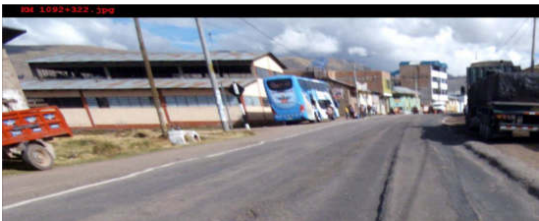
Tramo Sicuani-Combapata. Múltiples cocodrilos con deformaciones
