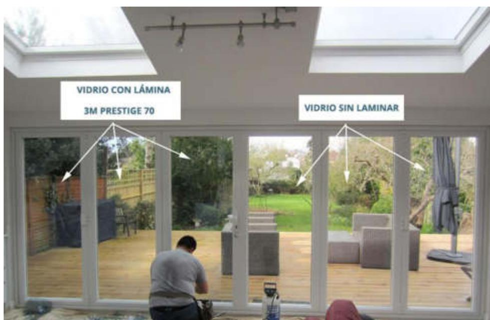
Figura N°83: Diferencia de vidrio con y sin lámina de control solar
