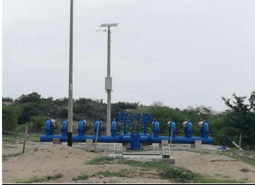
*Figura N°104: Cabezal de Riego*
