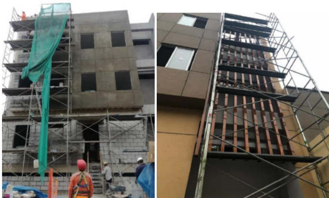
Figura 16. Imágenes de construcción y ampliación de Salas Velatorio.
