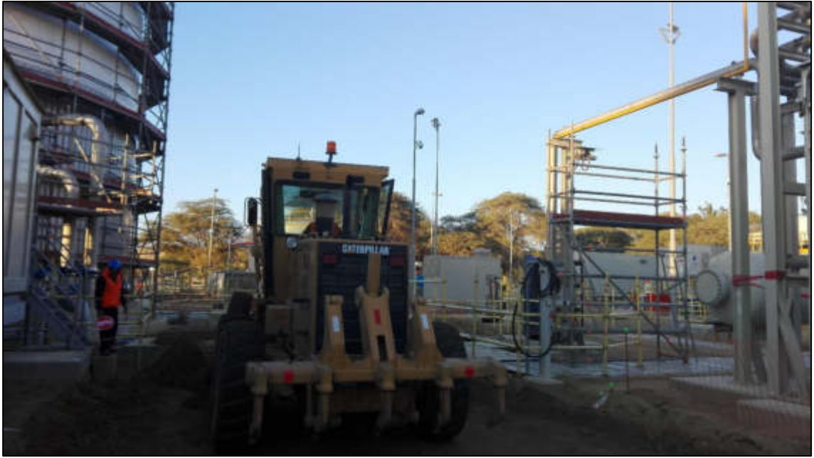
Fotografía 7: Uso de barandas y mallas de seguridad en obra
