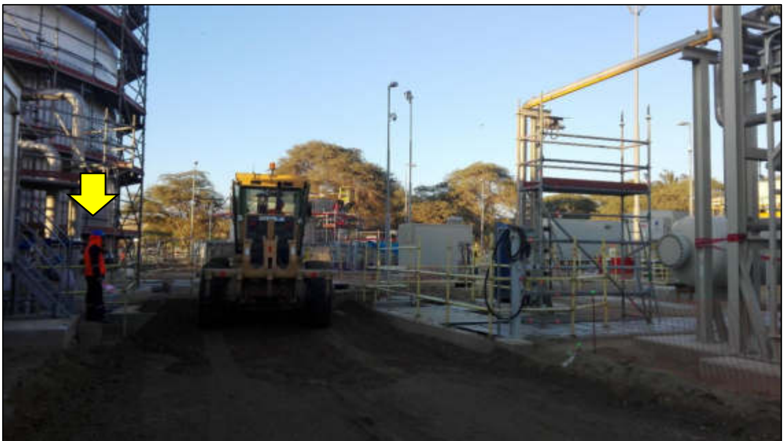
Fotografía 6: Vigías en la ejecución de la obra
