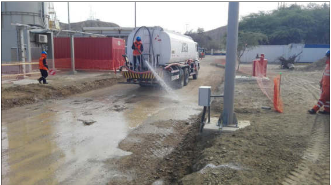
Fotografía 8: Uso de EPP completo y mallas de seguridad en obra
