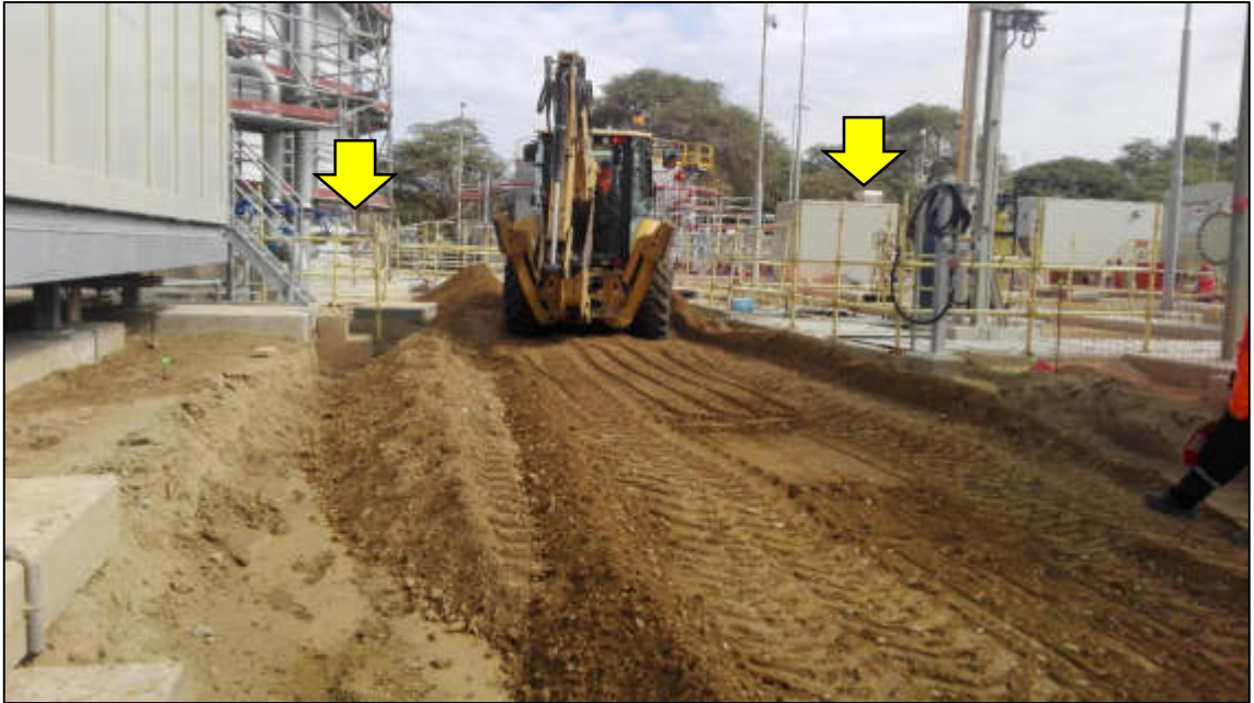
Fotografía 5: Uso de barandas y mallas de seguridad en obra
