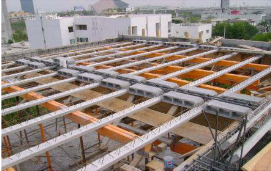
Figura 12. Techo aligerado de sistema ALITEC
