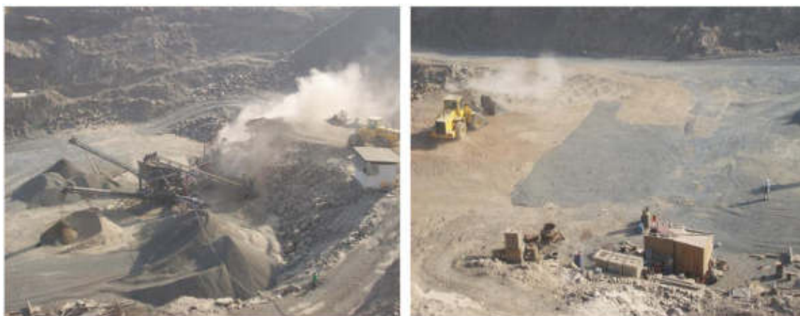
Figura 48 Chancadora Emulsiones y Asfaltos SAC
