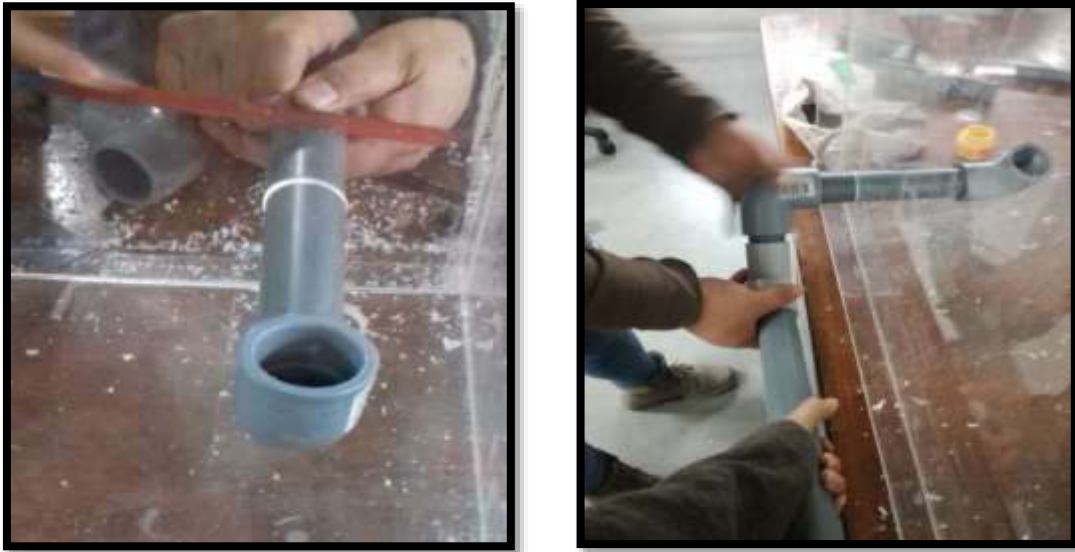
Figura 45. Proceso de instalación del tubo de PVC y codos
