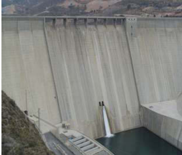
Figura 5. Presa de Rules ubicado en el cauce del río Guadalfeo, Granada
