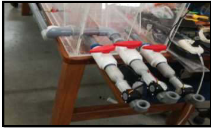
Figura 48. Instalación de sensores de flujo
