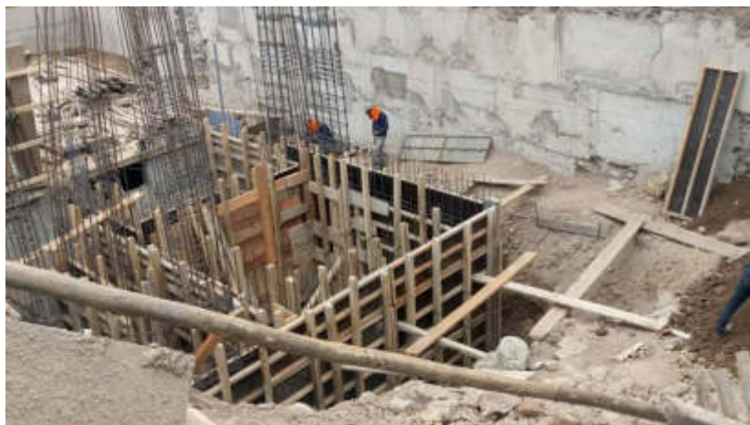
Figura N°07 Fotografía 1 de inspección de uso de los EPP
