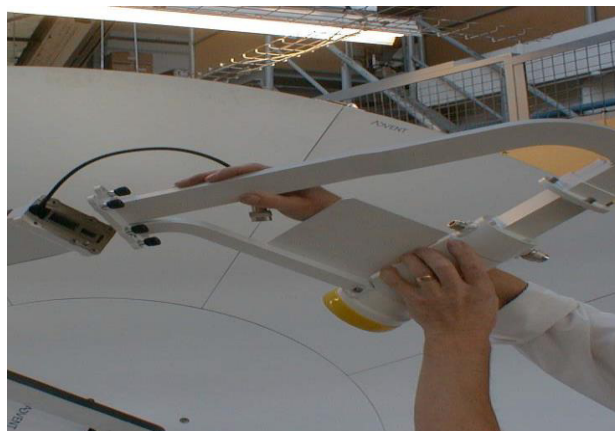
Figura 17. Instalación de Feeder
