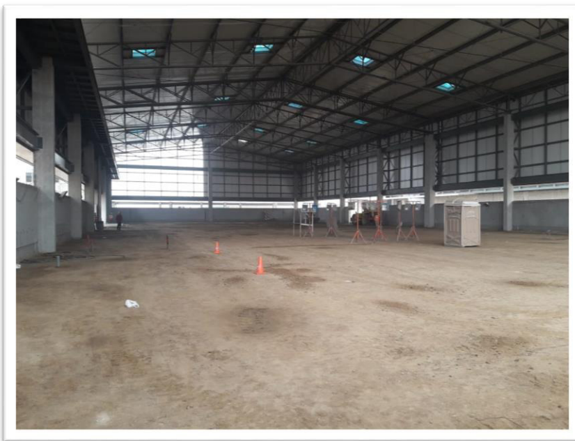
Foto 2: Nivelación de terreno para vaciado de losa – Edificio Materia Prima
