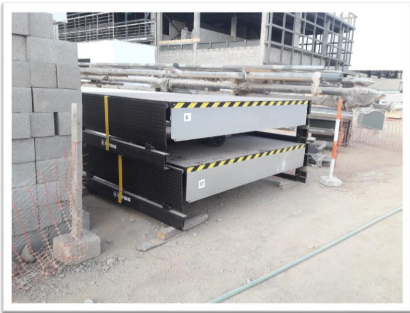
Foto 8: Mesas elevadoras para el patio de maniobras
