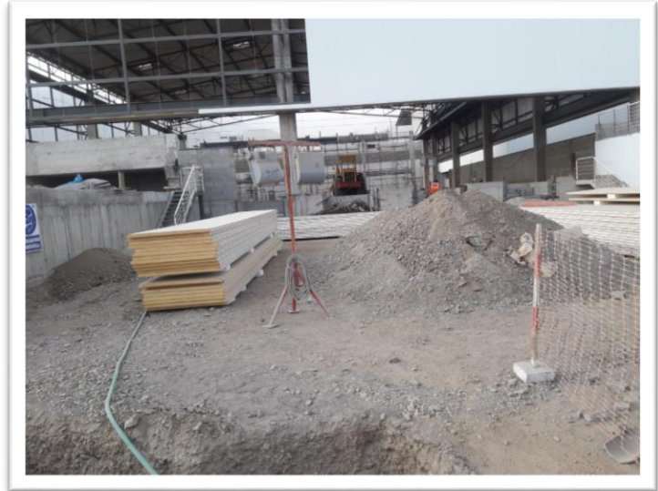
Foto 7: Zona de patio de maniobras
