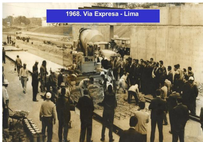
Figura 5. Construcción de la Vía Expresa, (Perú, 1968)
