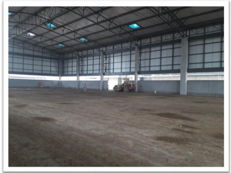
Foto 3: Nivelación de terreno para vaciado de losa con moto niveladora – Edificio Materia Prima
