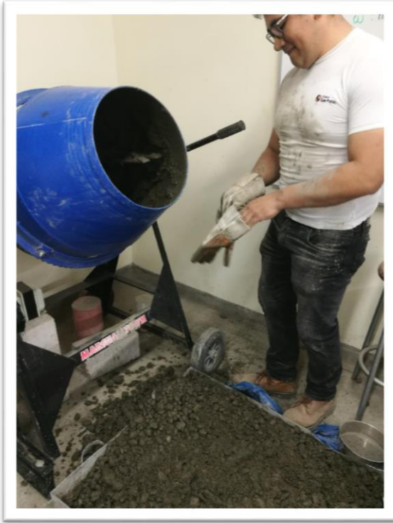
Foto 11: Elaboración del concreto para vaciar en las probetas y viguetas.
