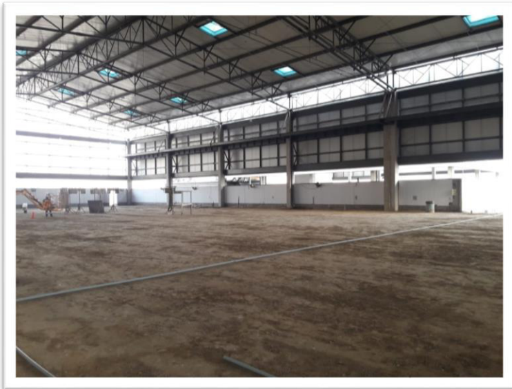
Foto 6: Almacén de producto terminado
