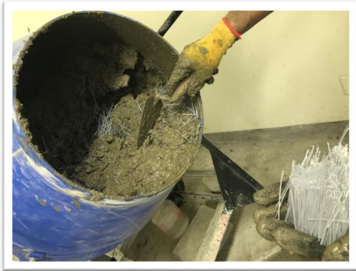
Foto 19: Elaboración de mezcla adicionando fibra sintética
