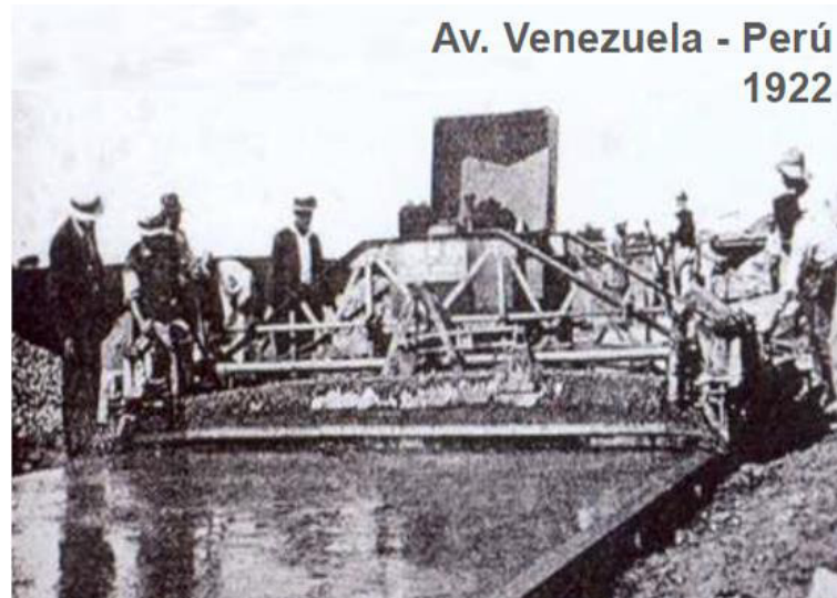
Figura 4. Pavimento de Concreto en la Av. Venezuela (Perú, 1922)
