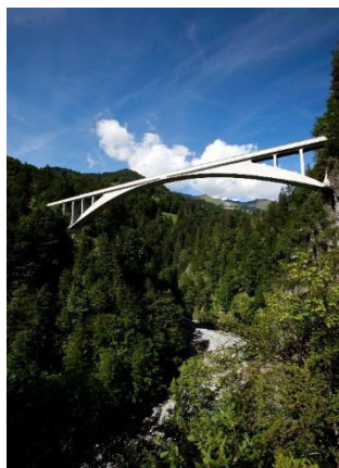
Figura 13: Puente Salginatobel en Suiza
