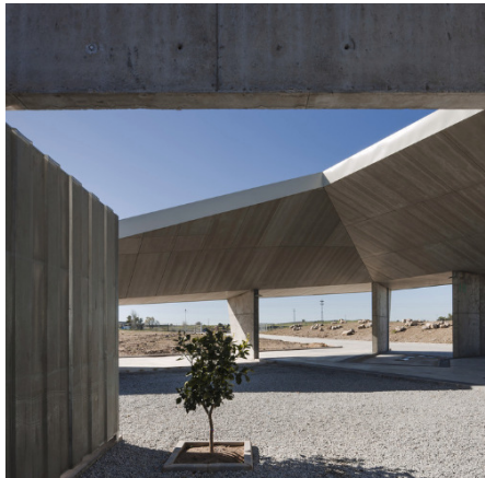
Imagen N° 20: Parte Externa del Terminal de Autobuses de Trujillo.
