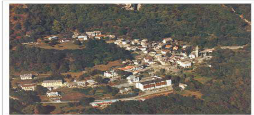
Figura 18. Vista del centro para ancianos, Suiza
