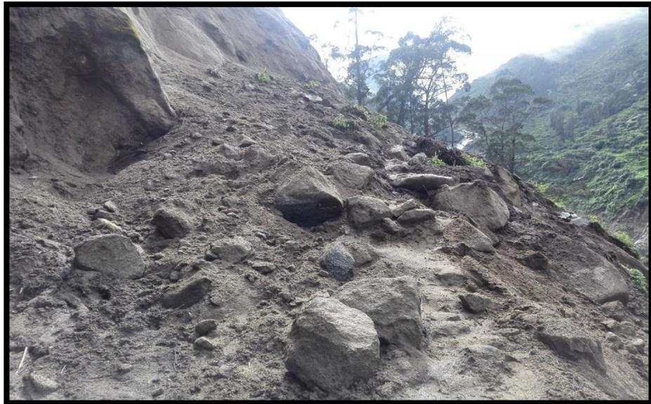
**Figura 32:** Caída de huayco sobre la carretera impidiendo el paso de vehículos con un volumen aproximado de 400 m<sup>3</sup> en el tramo Vichka – Huayra.
