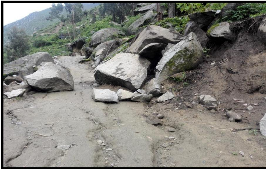
**Figura 30:** Deslizamiento de grandes rocas sobre la vía que requiere de perforación y voladura para la apertura de la vía.
