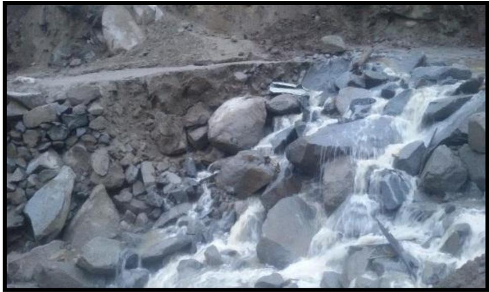
**Figura 26:** Caída del muro seco de la plataforma de la carretera en el sector de Vichka la socavación de la plataforma de la carretera por el recorrido del agua. Se requiere realizar nuevas alternativas de diseño, de lo cual es el tema de la tesis.
