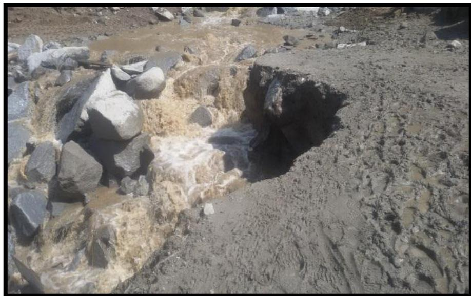
**Figura 25:** Socavación y deterioro de la carretera por la crecida del río Chancay en la entrada a Huayra por las lluvias presentadas en la temporada.
