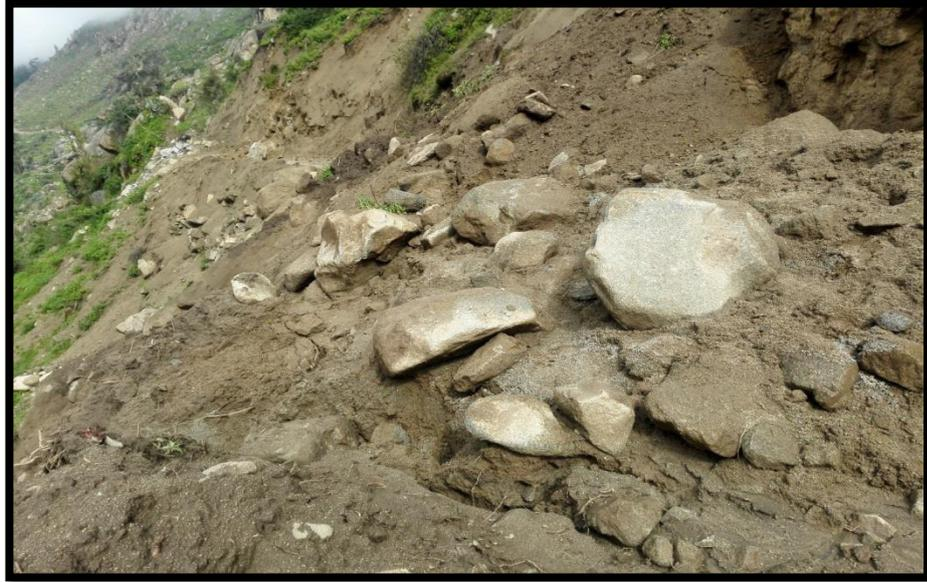
**Figura 31:** Caída de grandes piedras sobre la vía en el sector Huayra que requiere de perforación y voladura y su eliminación de la roca por la presencia de terrenos agrícolas.
