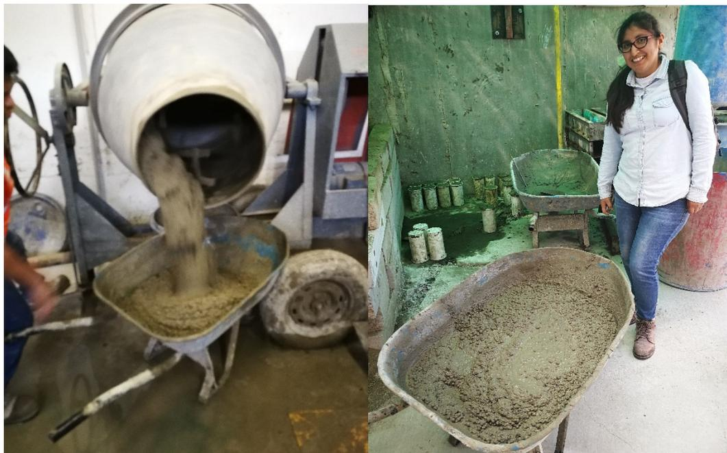
**Fotografía 9:** Vaciado de concreto elaborado con arcilla expandida [Fotografías de Jonatán Vera]. (Lima. 2018).
