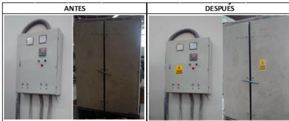
Figura 66 Implementación de señales de advertencia Fuente: Tomado en IND. AMERICAN PLAST PERÚ SAC Elaboración: Los autores
