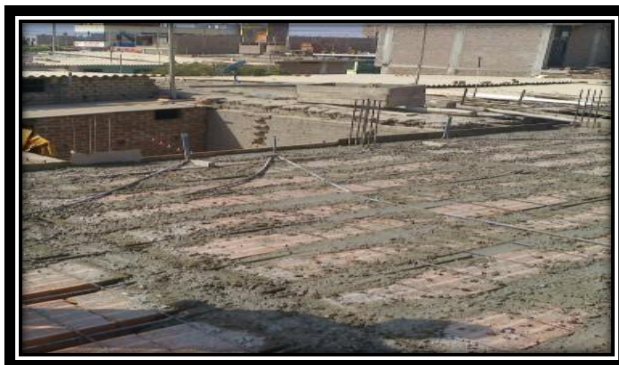
VACEADO DE LOSA
