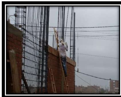
VACEADO DE VIGA
