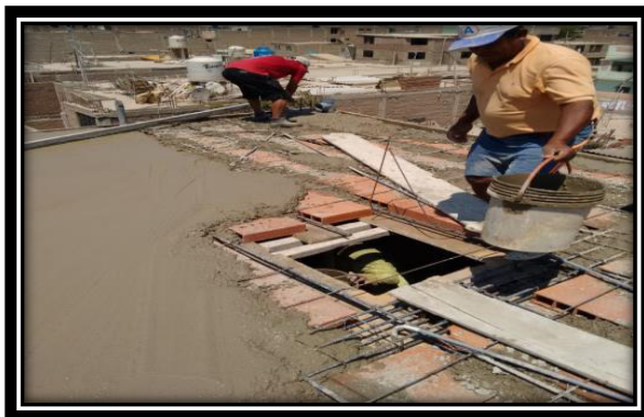
VACEADO DE LOSA
