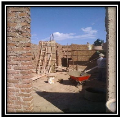
ENCOFRADO Y VACEADO DE COLUMNA
