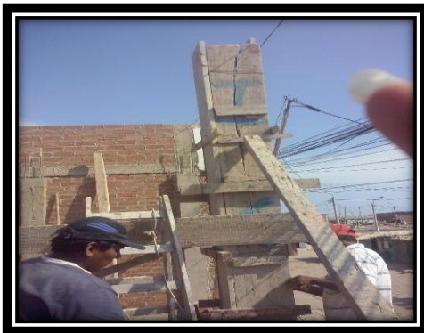
ENCOFRADO Y VACEADO DE COLUMNAS
