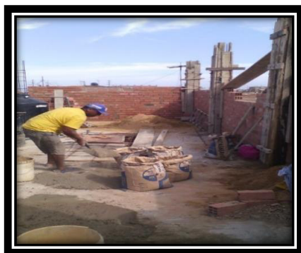
ENCOFRADO Y VACEADO DE COLUMNA
