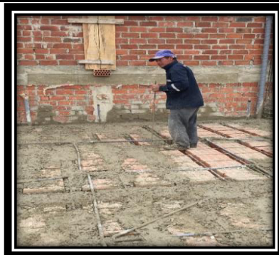
VACEADO DE LOSA
