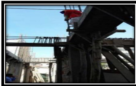
VACEADO DE VIGA
