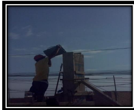
ENCOFRADO Y VACEADO DE COLUMNAS
