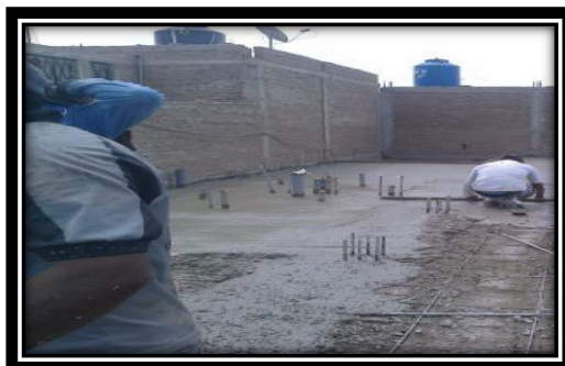
VACEADO DE LOSA
