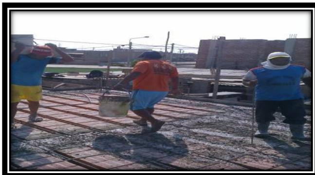
VACEADO DE VIGA
