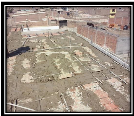
VACEADO DE LOSA
