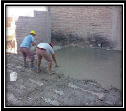
VACEADO DE LOSA
