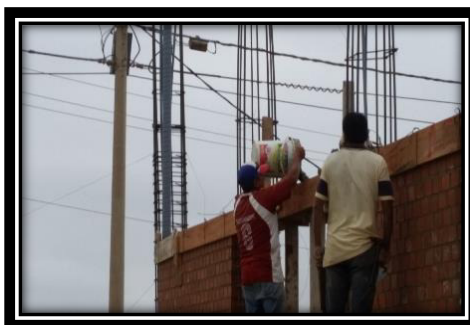
VACEADO DE VIGA
