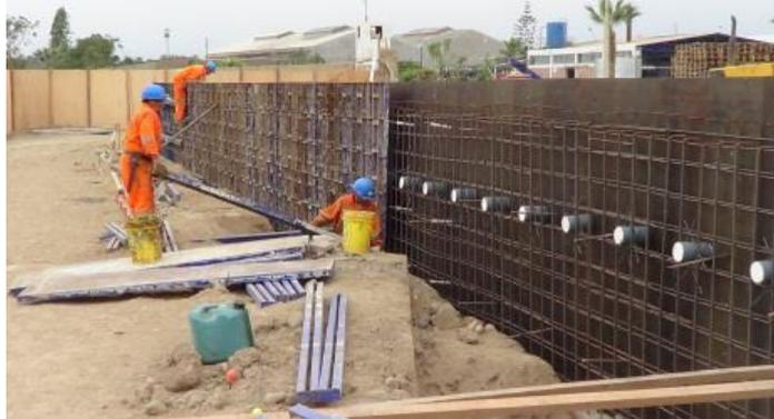
Figura 33: Encofrado metálico caravista en muro de contención
