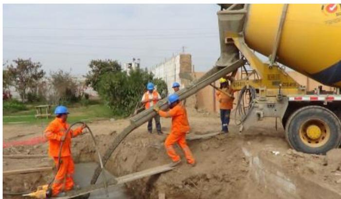
Figura 30: concreto premezclado  $F'c=140\text{kg/cm}^2$  para solado de cimientos
