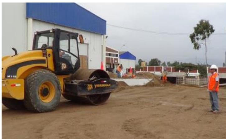
Figura 28: Compactación de pisos en capas de 20 cm. con afirmado
