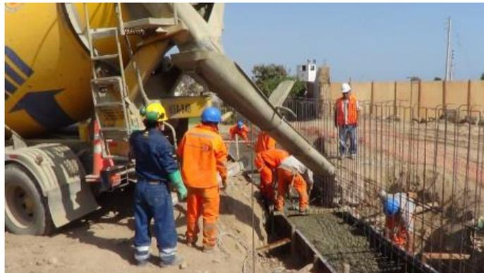
Figura 32: Concreto para Cimiento de Muro de Contención
