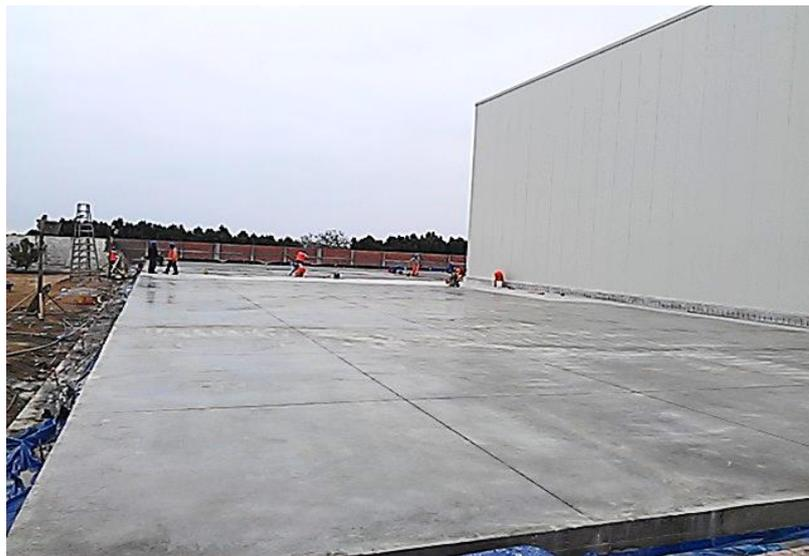
Figura 41: Juntas de contracción y construcción en piso de cámaras
