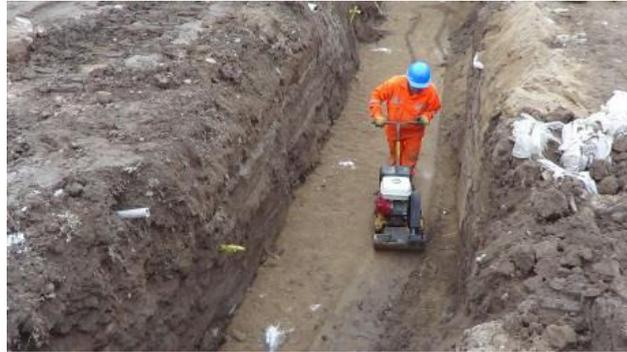
Figura 18: Compactación de zanjas de cimentación
