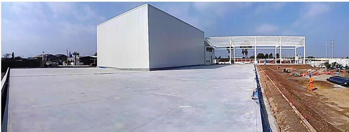
Figura 42: Piso de concreto armado en Cámaras de Congelado
