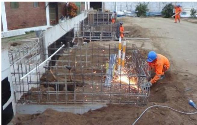
Figura 37: Acero de refuerzo  $F'y=4200 \text{ kg/cm}^2$  para Niveladores de Andén
