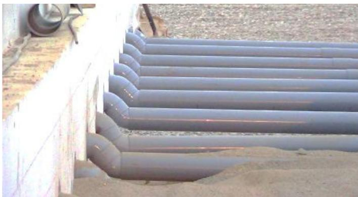
Figura 26: Tubería PVC 4" para sistema de venteo
