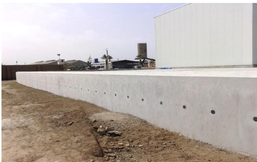
Figura 43: Acabado caravista de concreto armado en muros de contención
