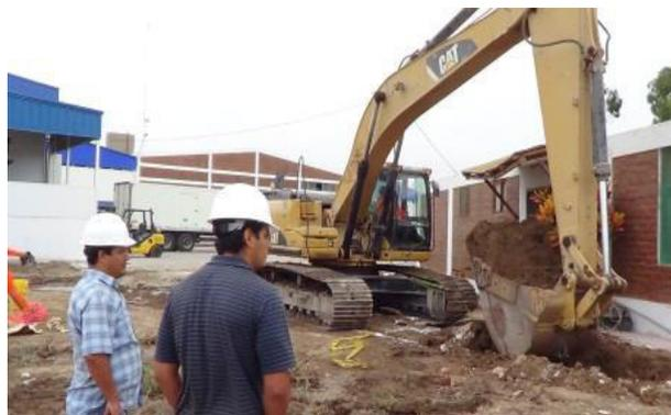
Figura 19: Excavación de zanjas para cimentación
