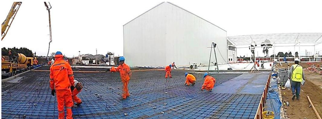
Figura 23: Acero de refuerzo en Piso de Cámaras de Congelado
