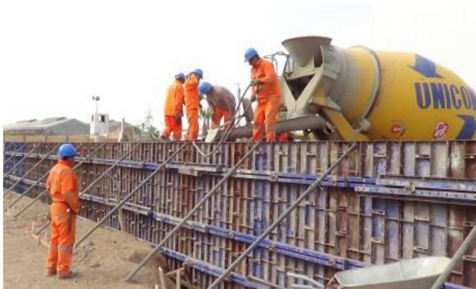
Figura 34: Concreto premezclado  $F'c=210\text{kg/cm}^2$  en Muro de Contención
