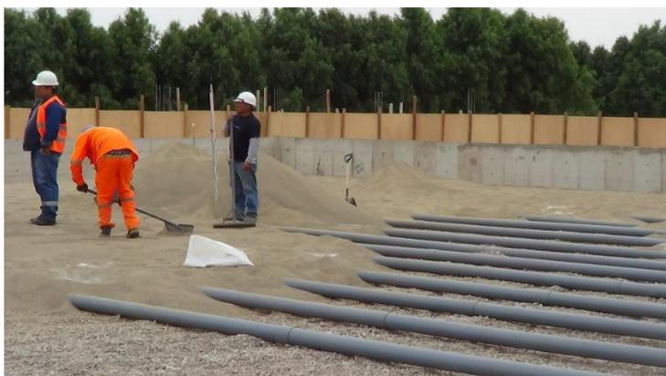
Figura 25: Sistema de tuberías de venteo bajo el piso de Cámaras de Congelado
