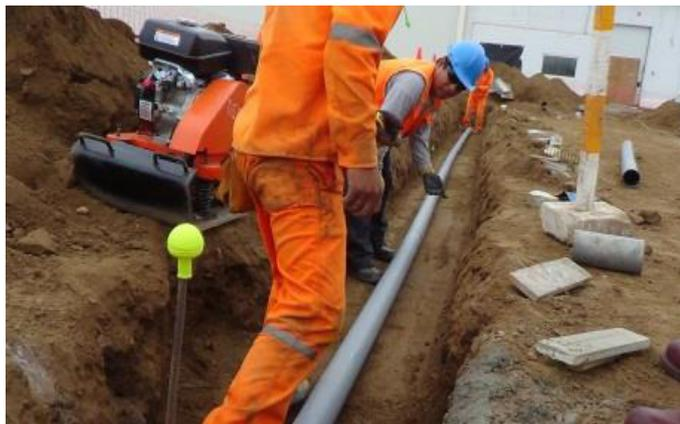
Figura 45: Sistema de desagüe industrial
