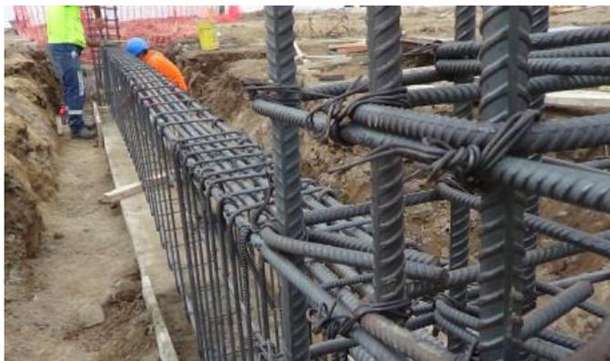
Figura 36: Acero de refuerzo  $F'c=4200\text{kg/cm}^2$  para Vigas de Cimentación
