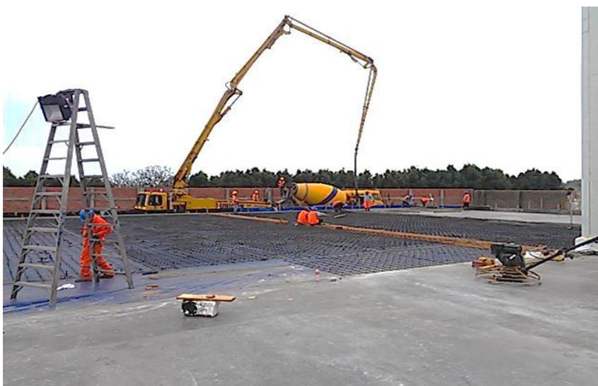
Figura 40: Losa de concreto para Piso en Cámaras de Congelado
