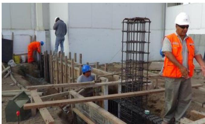
Figura 35: Acero de refuerzo en Pedestales (Columnas)
