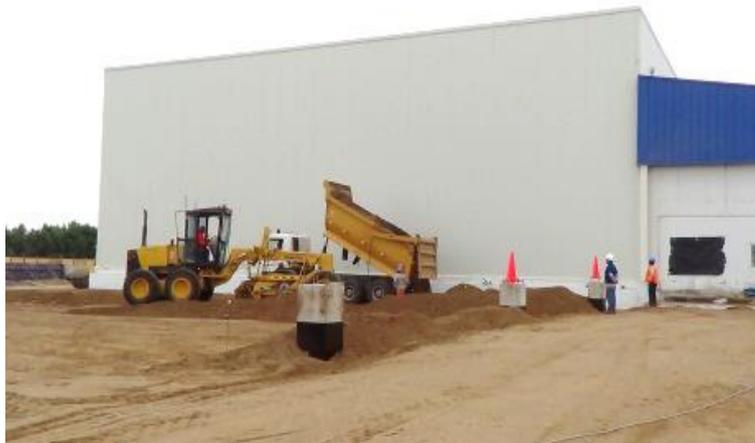
Figura 21: Relleno y nivelación de terreno con afirmado
