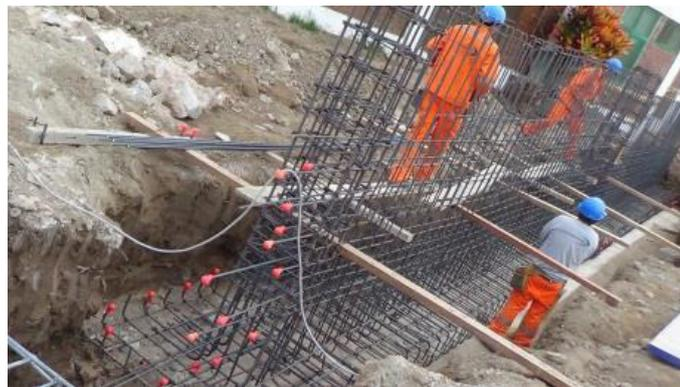
Figura 31: Acero de refuerzo para Muros de Contención
