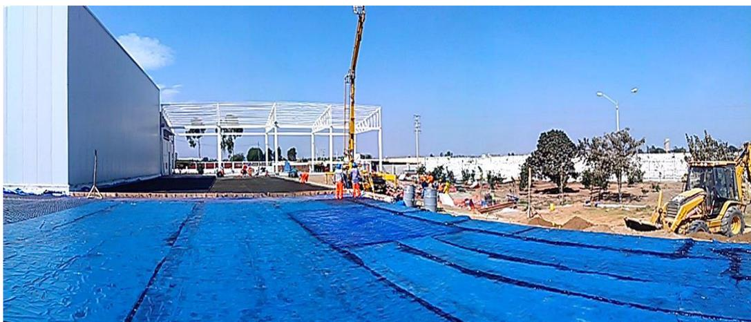
Figura 24: Aplicación de poliestireno en piso de Cámaras de Congelado
