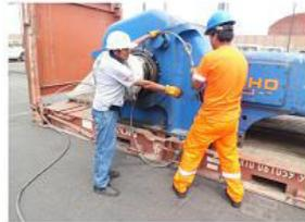
Trincando de maquinarias con cables para exportación
