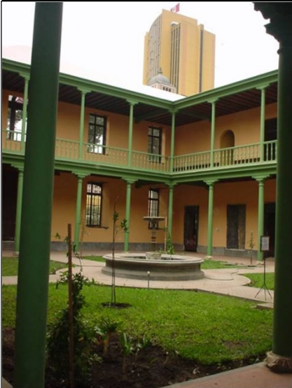
Figura 38: Planta de intervención de la Casona de San Marcos (superior), estado pre-intervención Patio de Chicos (medio), Patio de Derecho post-intervención (inferior) Fuente: Revista DEVENIR #3, 2015
