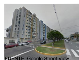
Aparición de vivienda de densidad alta en la zona proyectada como comercio
